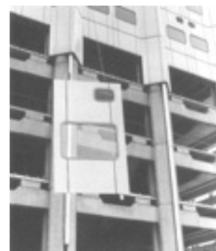
AFBEELDING 2.21 HET PREFAB GEVELEMENT, DIJKZIGT ROTTERDAM
