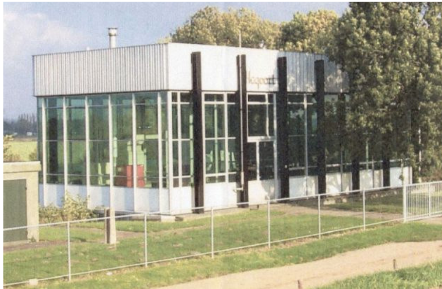
5 OPPERVLAK- GEMAAL DRONGELEN UIT H. POSTEL EN CT ONBEKEND
