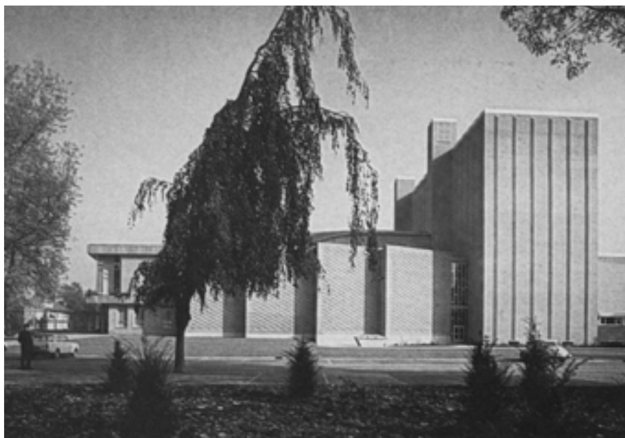
AFBEELDING 3.4 AAN DE ZIJKANT VAN DE STADSSCHOUWBURG IN EINDHOVEN WAS VOLDOENDE PARKEERRUIMTE
