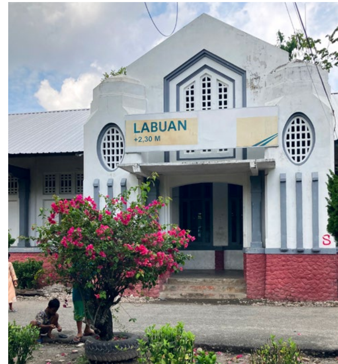
Het koloniale stationsgebouw aan de lijn Medan-Belawan wordt niet meer gebruikt
