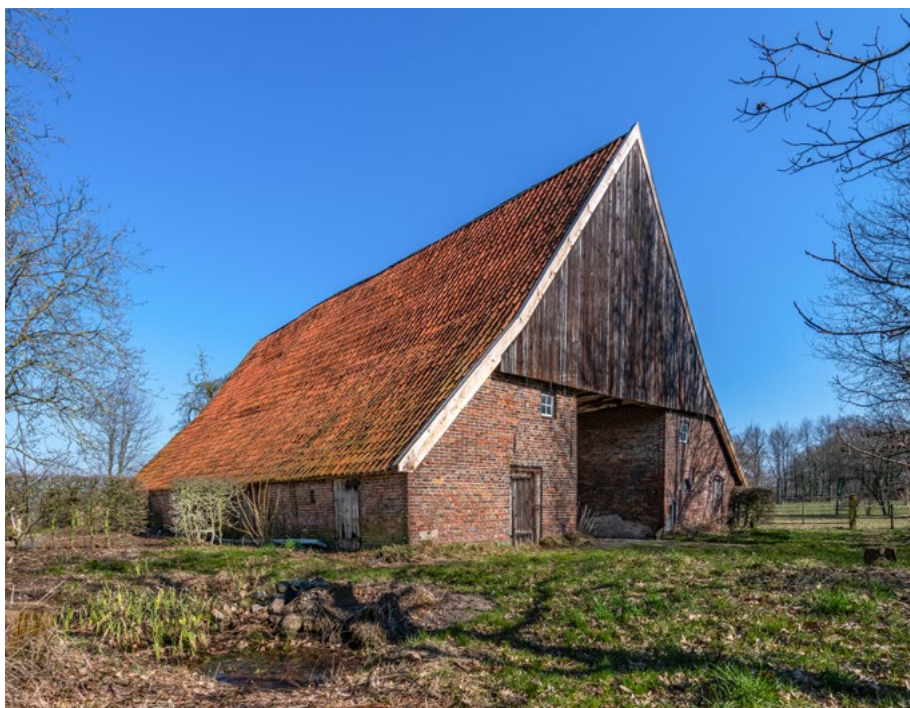
Aan de achterkant heeft Klein Kattendam terugliggende inrijdeuren
