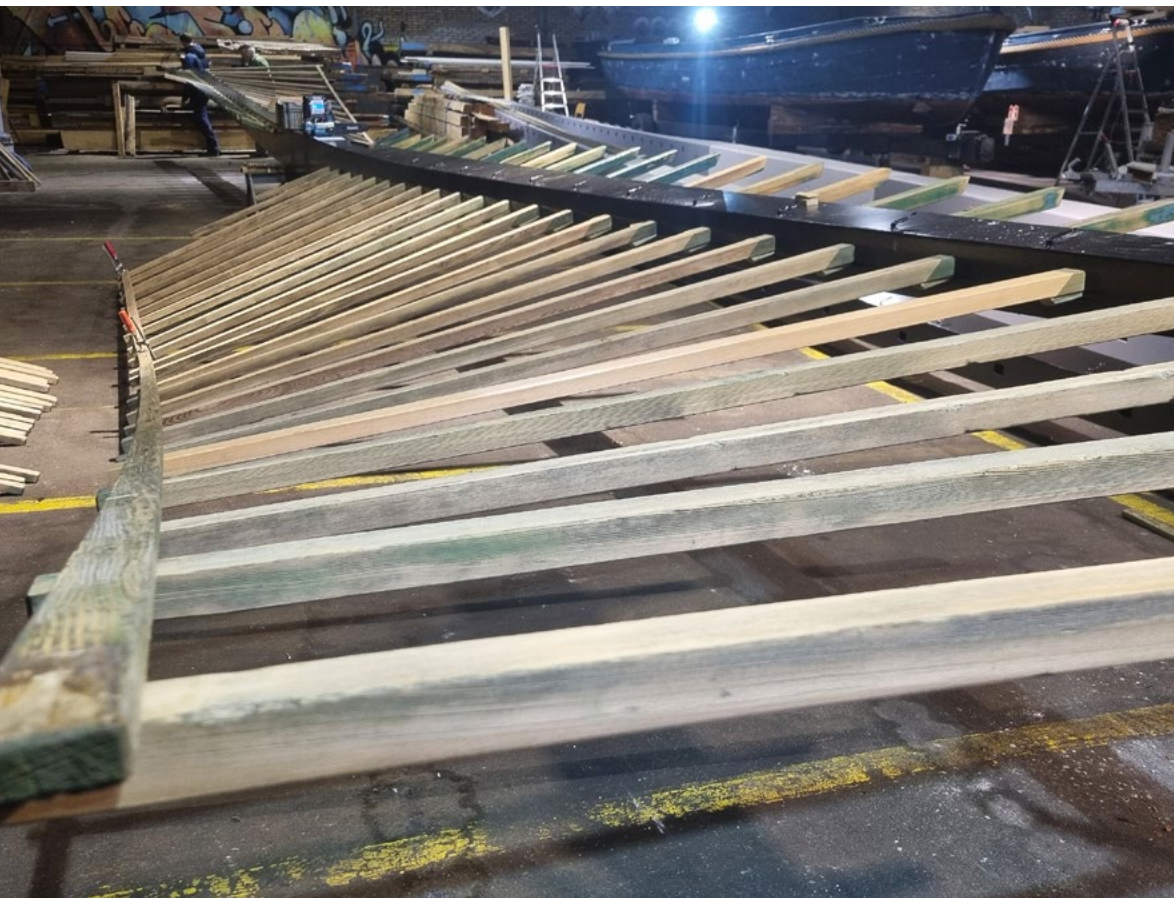
Een molenroede wordt in de werkplaats 'opgehekt', zodat hij weer jaren wind kan vangen
