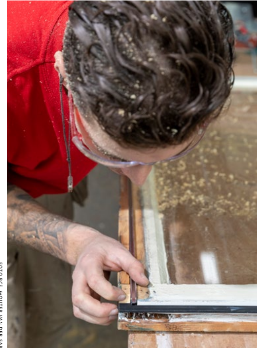
De kieren bij draaiende ramen kun je vaak goed met rubberen strips afsluiten
