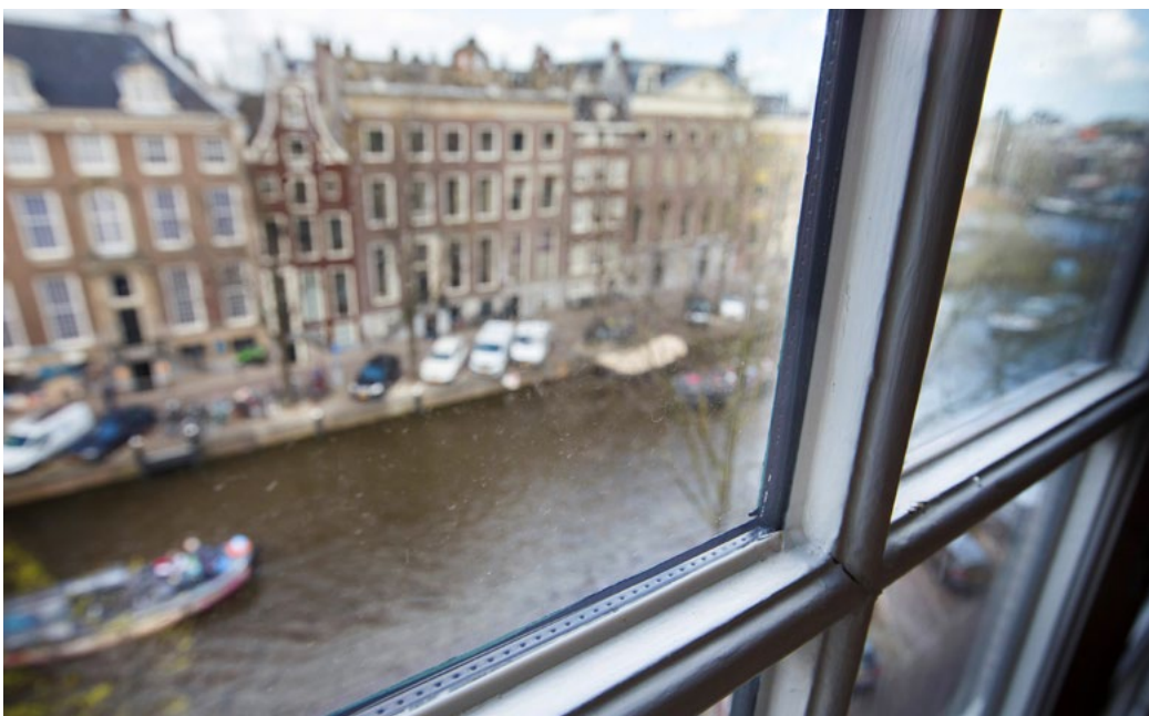
Dit rijksmonument aan de Herengracht in Amsterdam is van dun dubbelglas voorzien
