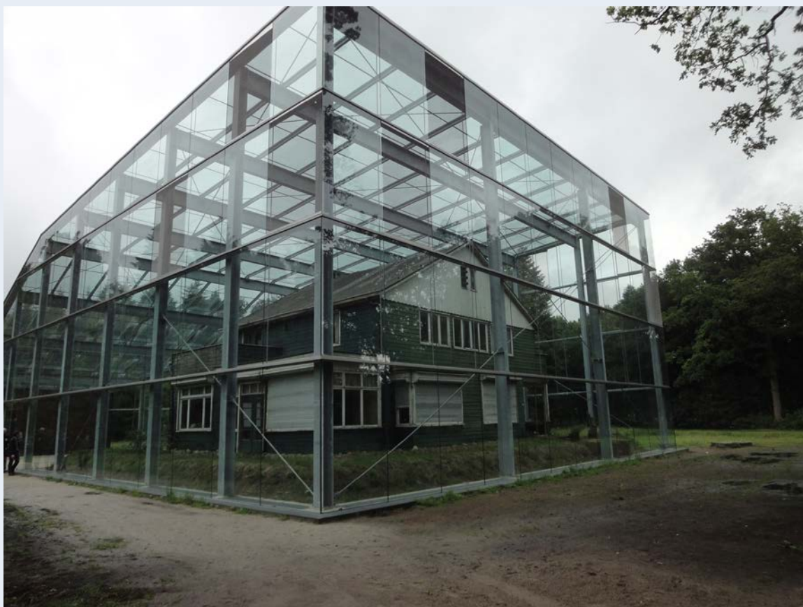
Afbeelding 42. De houten woning van de kampcommandant van Kamp Westerbork heeft ruim 70 jaar lang het Nederlands klimaat doorstaan en is vanaf 2015 door een glazen overkapping beschermd tegen weersinvloeden (foto: Bart Ankersmit).
