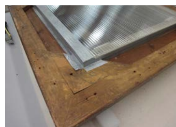
6. Het schilderij wordt met klemmen op zijn plaats gehouden. Op het balsahout wordt kanaalplaat aangebracht. Die wordt met aluminium tape luchtdicht afgeplakt.
