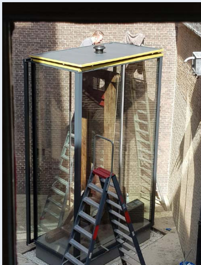
Afbeelding 8. Links: een schematische dwarsdoorsnede van de vitrine voor de guillotine van Rijksmuseum de Gevangenpoort. Rechts: de opbouw van de vitrine op de binnenplaats van het museum (foto: Sara van Doorn).
