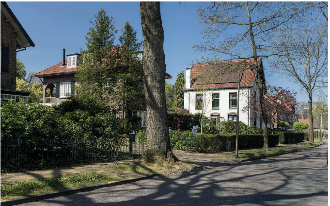
Zonnepanelen in aangepaste kleur aan de Prinses Marielaan in het beschermd gezicht Amersfoort-Bergkwartier, Amersfoort.
