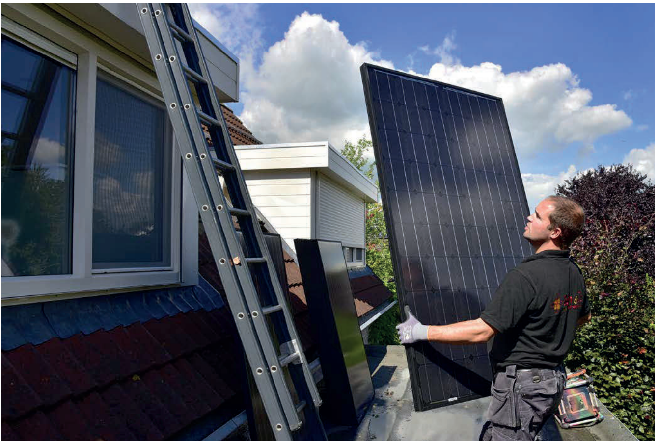
Het plaatsen van egaal zwarte zonnepanelen op het achterdakvlak van een woonhuis.
