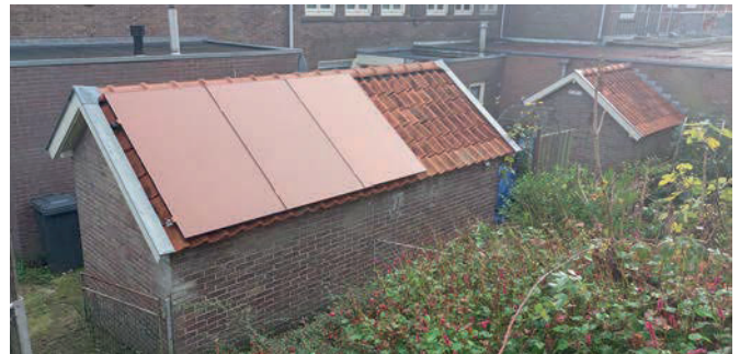
Arnhem, beschermde stadsgezicht De Geitenkamp, proef met zonnepanelen op kleur.
