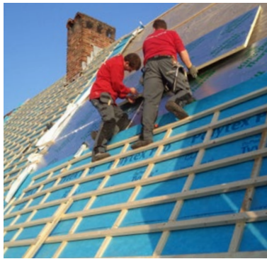
Een monumentaal dak wordt geïsoleerd
