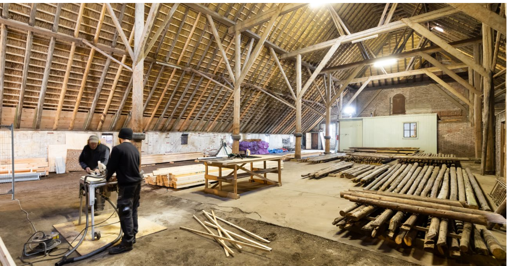
Bouwwakkers in de schuur van Occo Reintiesheerd. In de bijschuur maken ze een woning
