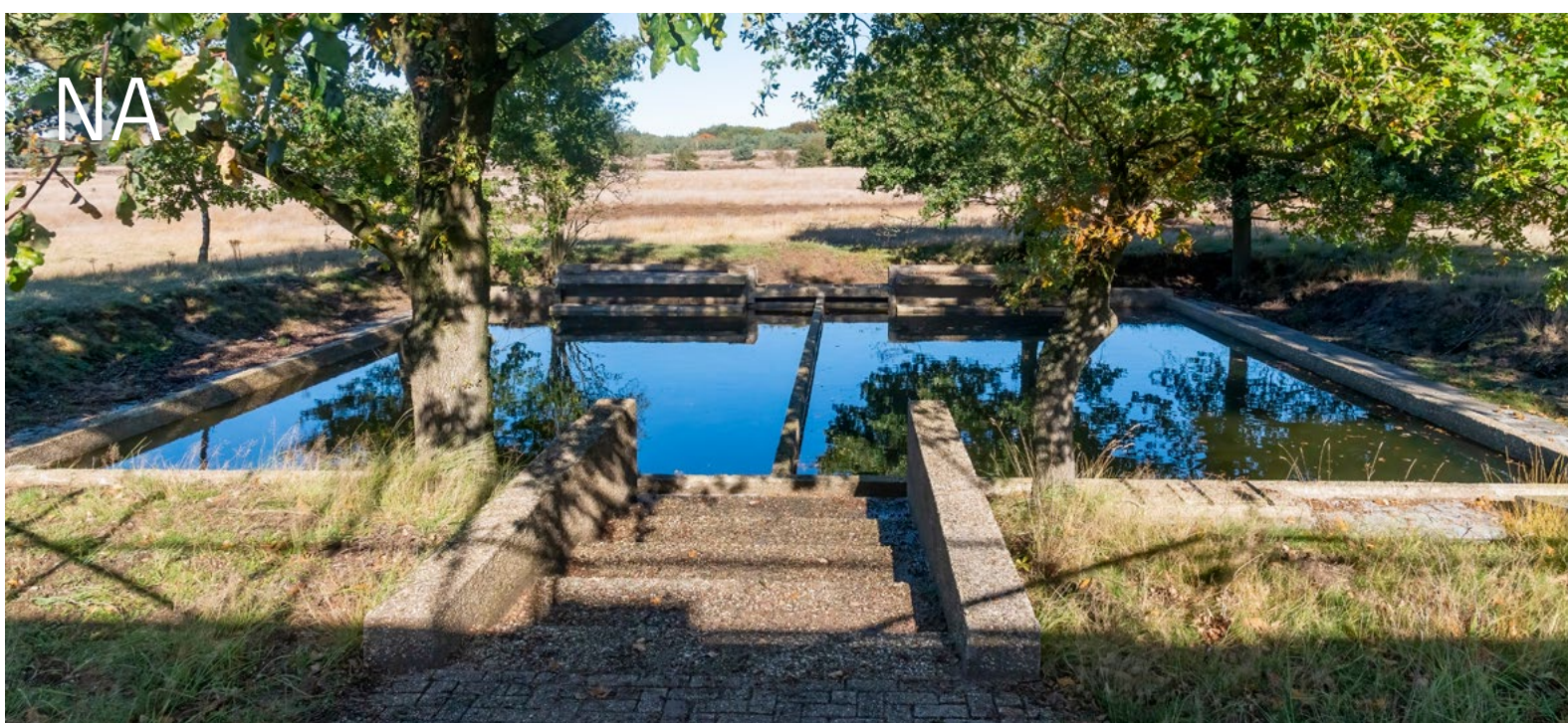
2023: Nu is het beton kundig gerestaureerd. De wapening ligt niet langer bloot en de vijvers gaan niet langer op in de natuur
