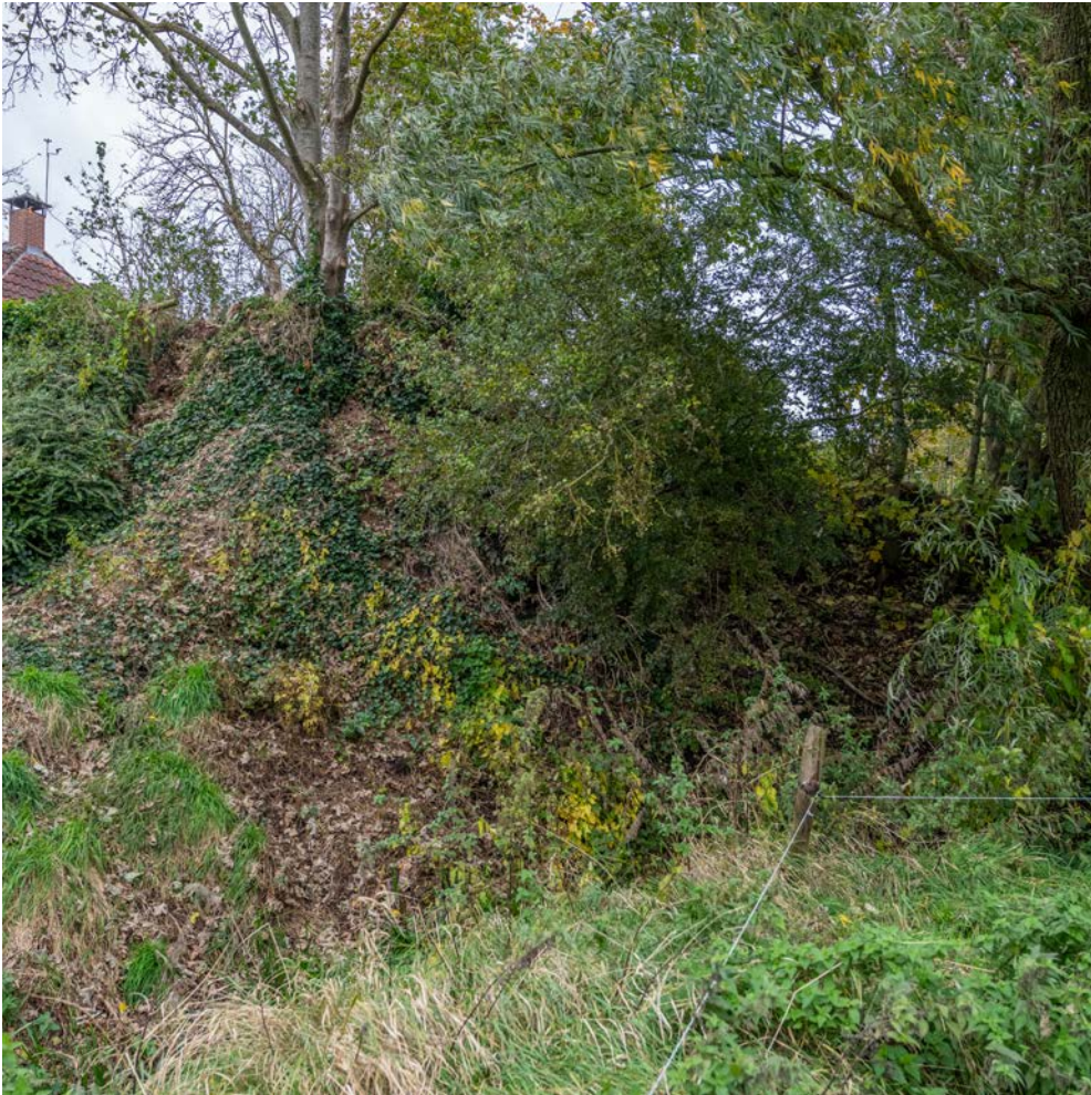
Figuur 4: Het hoogste punt van de steilkant. De erosie en afbrokkeling is hier goed te zien. De bomen bovenaan de steilkant zijn door de erosie van de steilkant gevoelig voor boomval. Foto: RCE, Jos Stöver.
