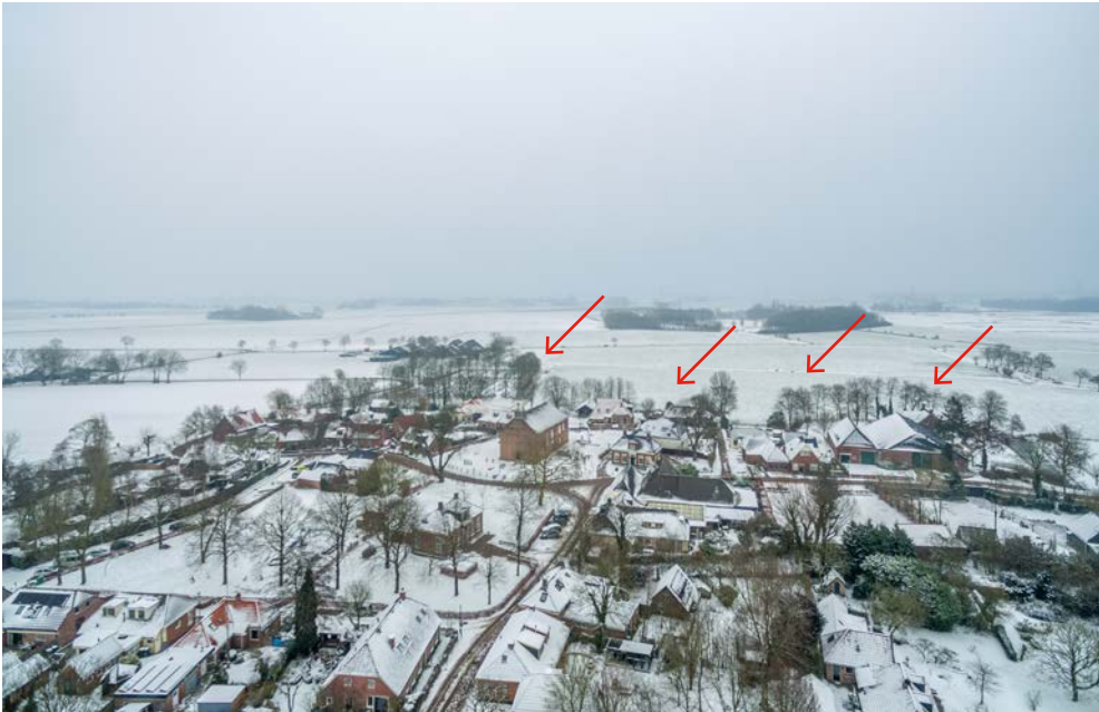
Figuur 2: Wirdum gezien vanuit het westen, met zicht op de dorpsbebouwing. De steilkant wordt aangegeven door de bomenrij achter de huizen en de kerk. Foto: RCE, Jos Stöver.
