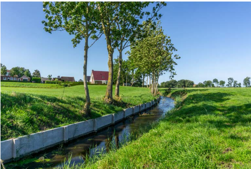
Figuur 5: de nieuw geplaatste betonnen schoeiing. De afgekalfde delen zijn aangevuld met grond die vrijkwam bij het verbreden van de tocht naar buiten toe. Foto: RCE, Jos Stöver
