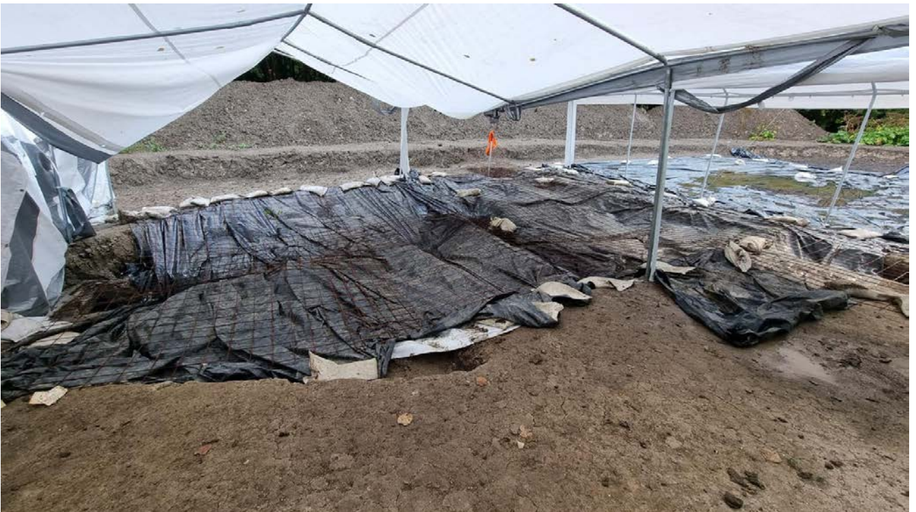
Afb. 6.3 Vervolgens is landbouwplastic geplaatst, dat is afgedekt met zandzakken en betonvluchtdraad.
