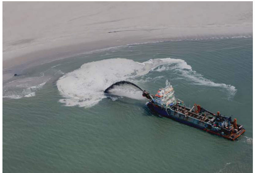
Afb. 1.2 Het opspuiten ( rainbowen ) van de Zandmotor met een sleeplopperzuiger, begin mei 2011 (bron: https://beeldbank.rws.nl , Rijkswaterstaat/Joop van Houdt).
