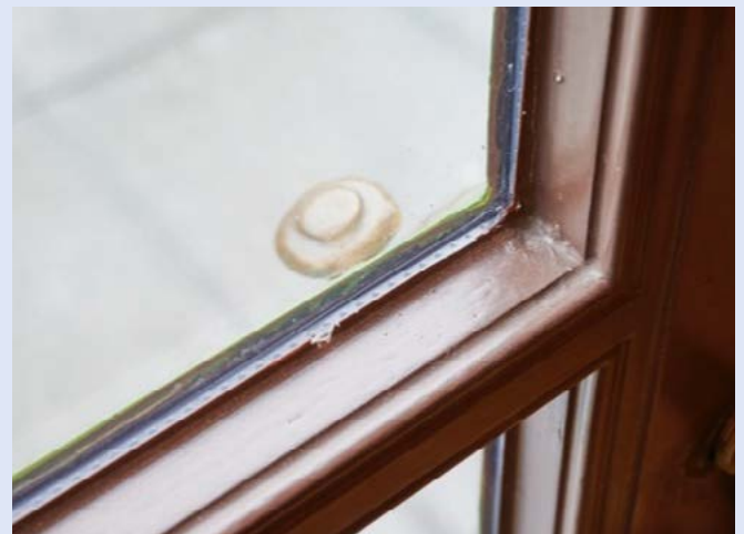
Dun dubbelglas past vanwege de geringe dikte vaker in historisch raamhout.
