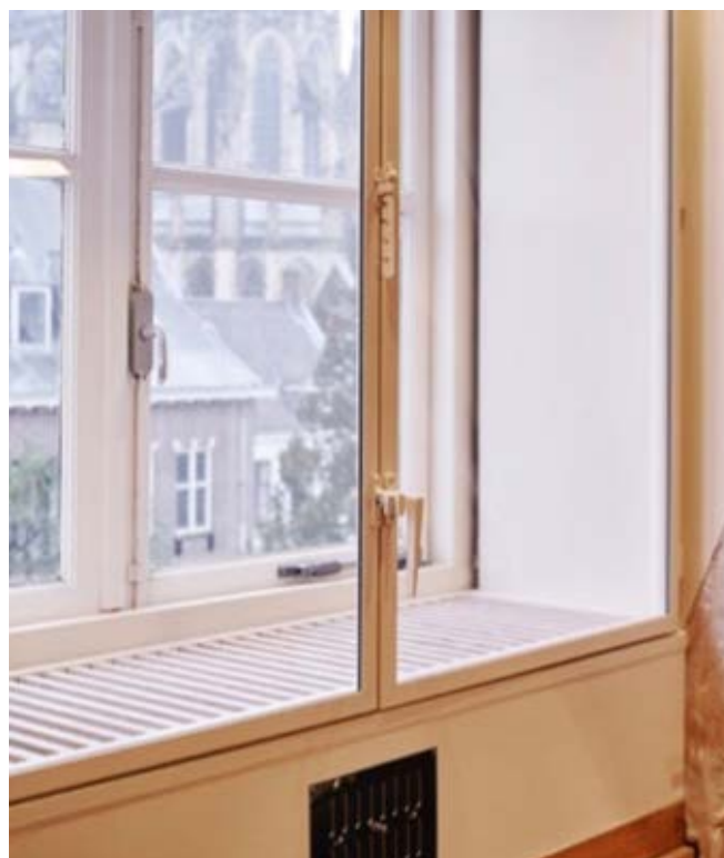
Een binnenvoorzetraam is een isolerende maatregel die aan de binnenzijde van een gebouw geplaatst wordt.
