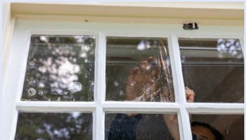
Glasfolies kunnen bijdragen aan energiebesparing in een historisch gebouw.
