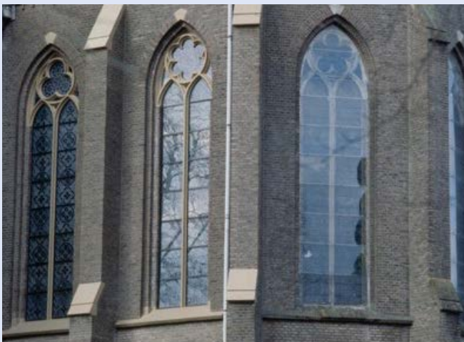
Buitenvoorzetramen zijn een manier om historisch glas te beschermen tegen vandalisme of stormschade.
