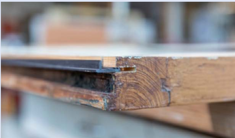
Kierdichting is de minst ingrijpende manier om historische vensters energiezuiniger te maken.
