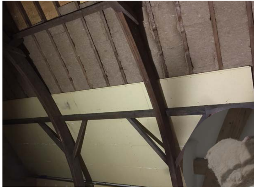
Het dak is geïsoleerd met jute en houtvezelplaten.
