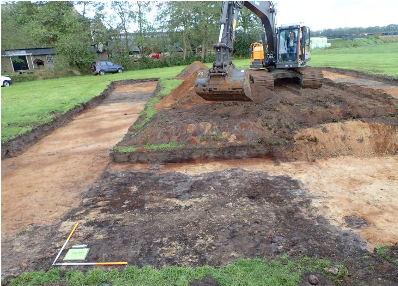
Afb. 5.20 Vooraan zijn de contouren zichtbaar van de grote kuil (s18) in het centrum van het omgrachte terrein. Op de achtergrond links de gracht.
