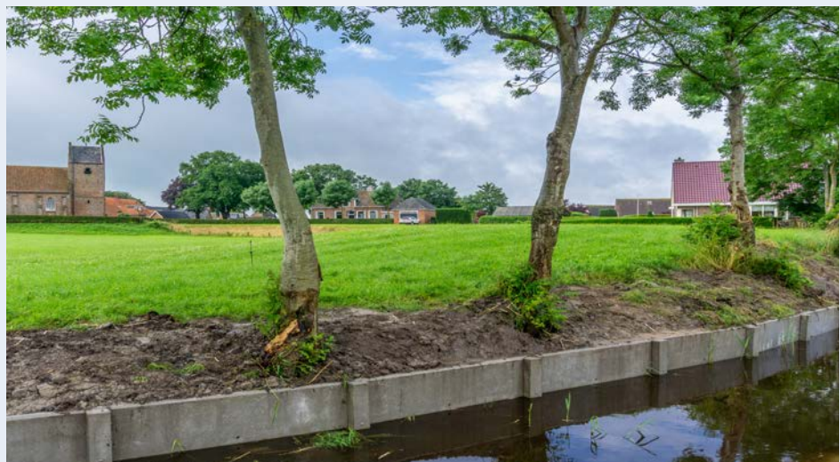
Afb. 7.4 De betonnen schoeiing ondersteunt de steilkant en beschermt tegen het stromende water in de sloot (foto: J. Stöver).
