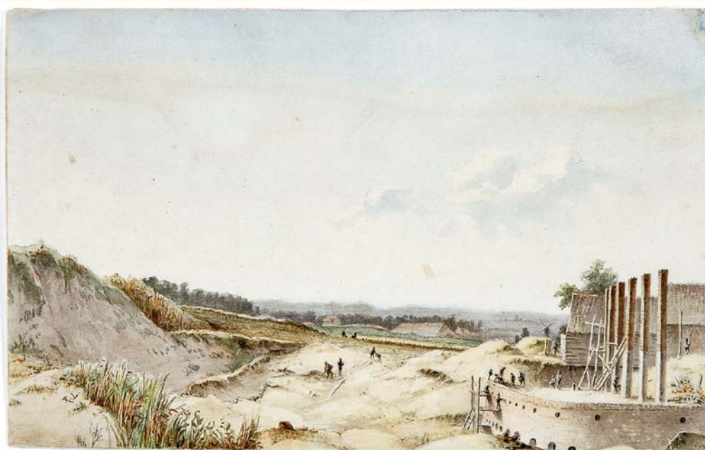
Afb. 14 Aquarel door Rudolphus Lauwerier, Bouw van het fort 'De verbrande Molen' op het Molenveld bij Nijmegen , 1861 (Collectie Museum Het Valkhof, Nijmegen).
