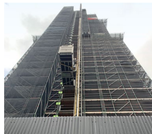
Ook de bouwlift aan de enorme steiger is ruim genoeg
