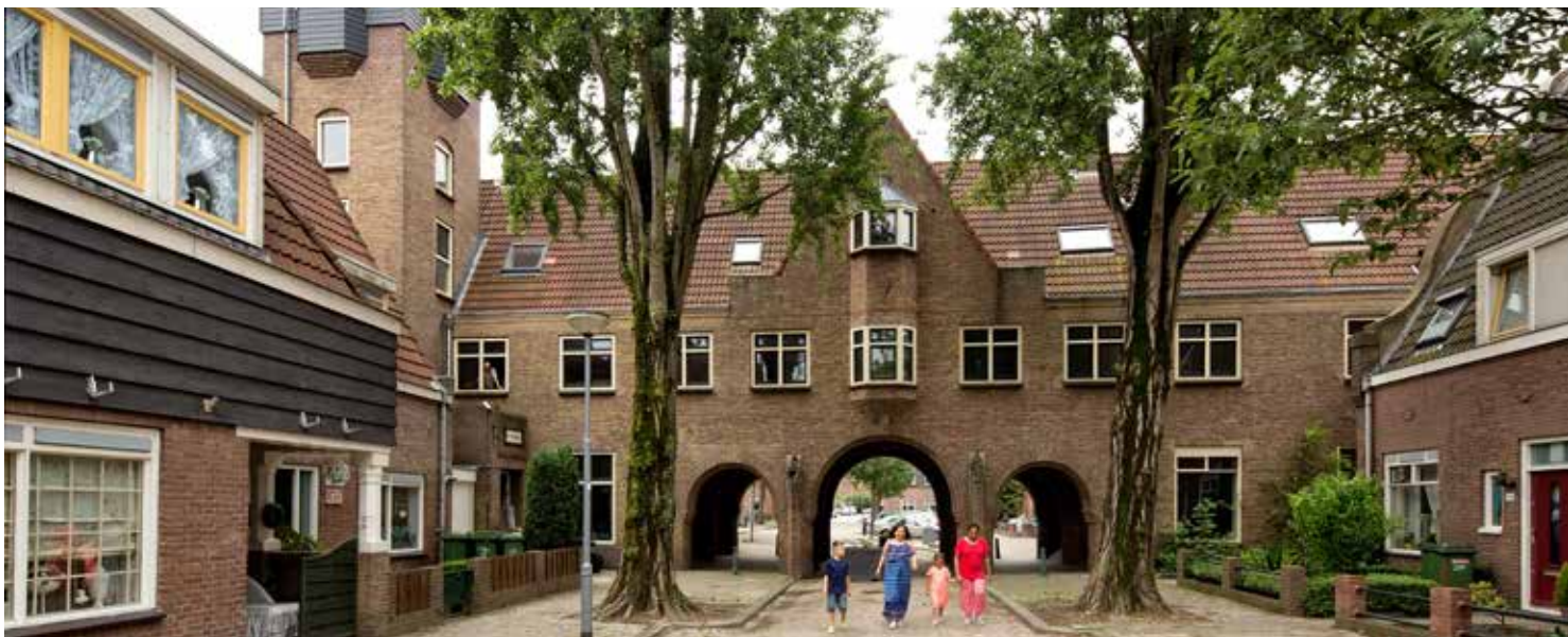
De Rotterdamse wijk Heijplaat is gebouwd in Engelse tuindorptraditie met een kleinschalige opzet. De wijk is in 2018 aangewezen als beschermd stadsgezicht. (Foto: Erik Fecken)
