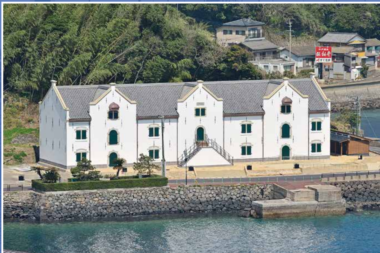
HET GERECONSTRUEERDE VOC-PAKHUIS BIJ OPLEVERING IN 2011 (FOTO R. VROLIJK).
