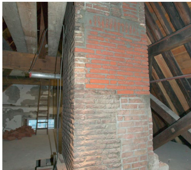
Schoorsteen in het stadhuis van Schiedam waarin duidelijk diverse reparaties zichtbaar zijn in het metselwerk, waarschijnlijk steeds uitgevoerd in nieuwe (ver) bouwfasen. Foto: Rijksdienst voor het Cultureel Erfgoed.
