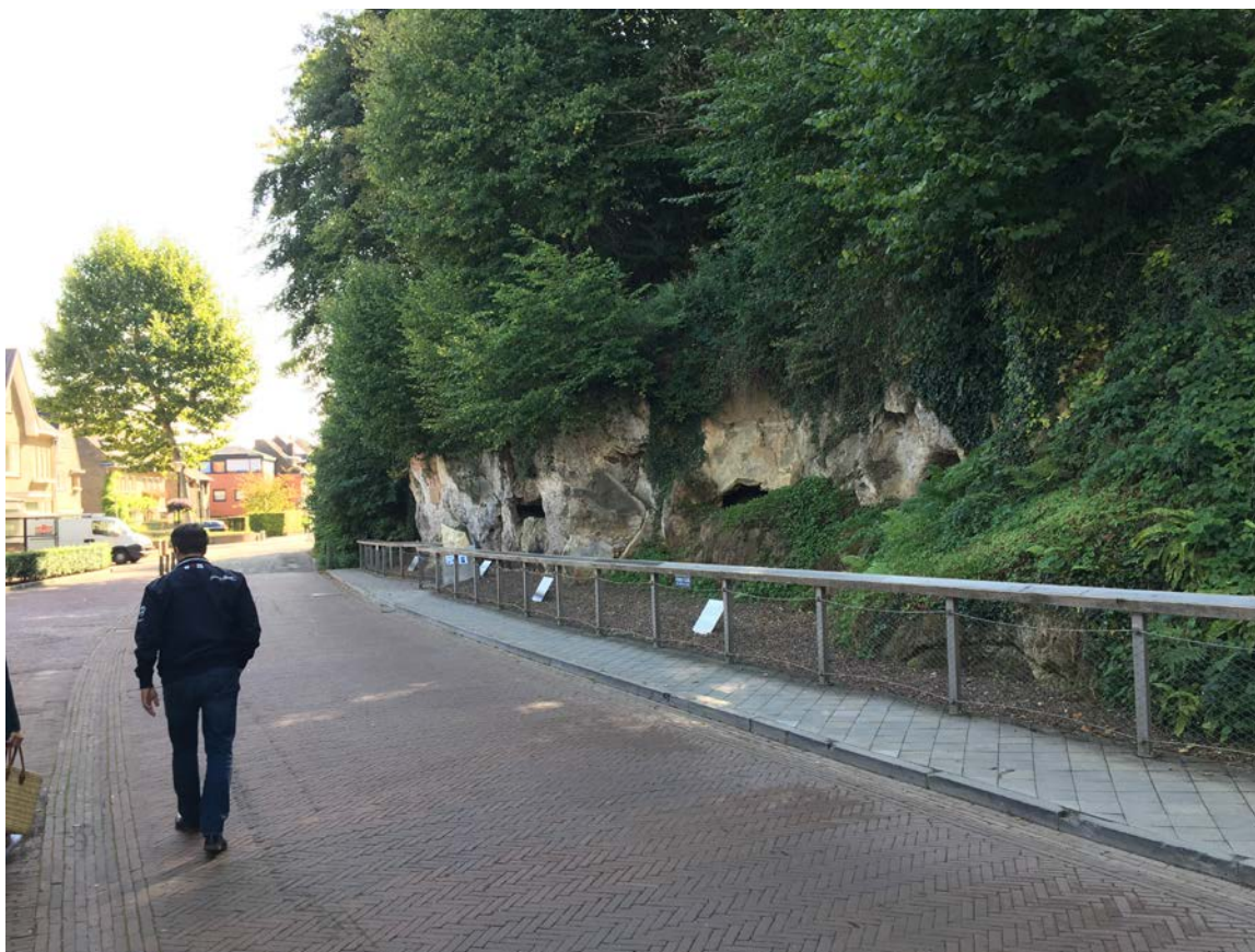
Valkenburg, Plenkertstraat. De 5500 jaar oude vuursteenmijnen worden aangetast door wortelwerking en scheurvorming (foto P. Schut).
