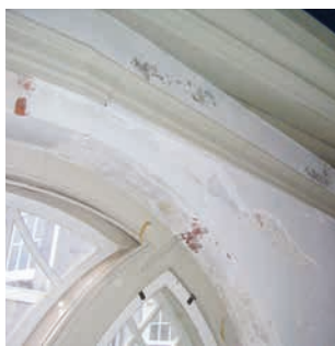
Vocht en zout beschadigen het pleisterwerk
