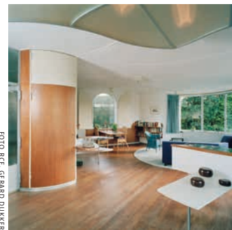
Nieuw bouw materiaal in een rijksmonument: zachtboard, triplex, figuurglas en stalen ramen en deuren
