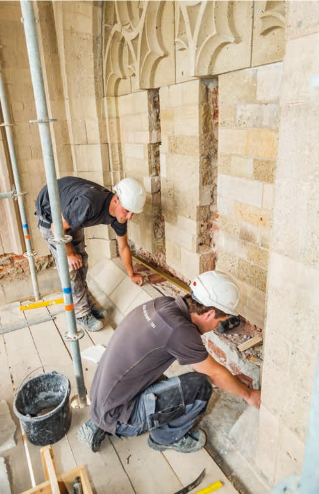
De nieuwe stenen worden nauwkeurig geplaatst
