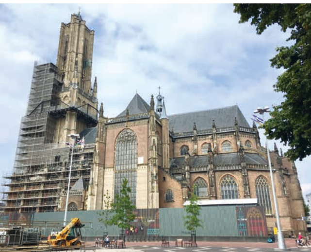
De kwetsbare Ettringer tufsteen wordt nu vervangen door een duurzamere soort
