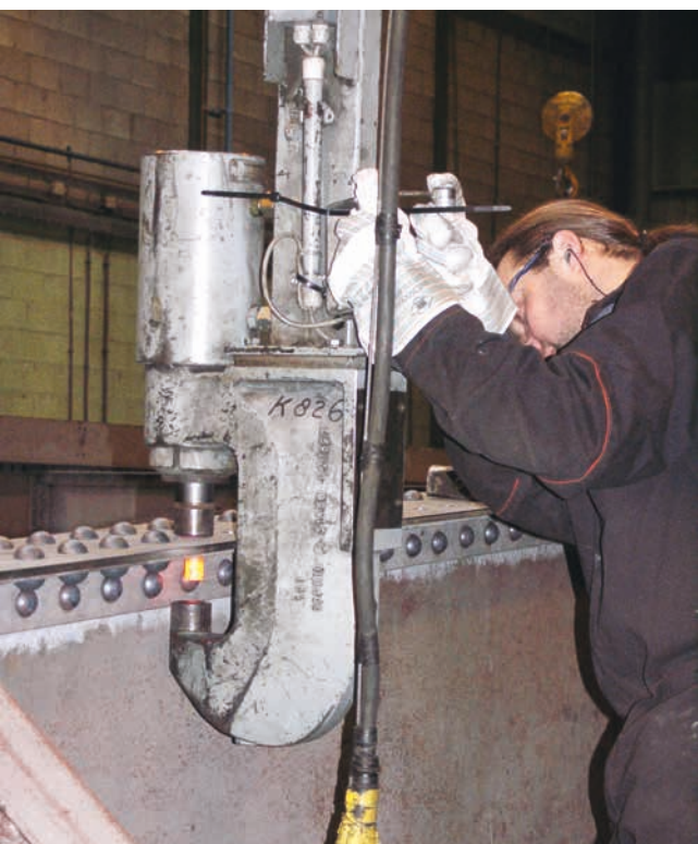
Ambachtelijke techniek in de huidige tijd: met klinknagels een brug herstellen
