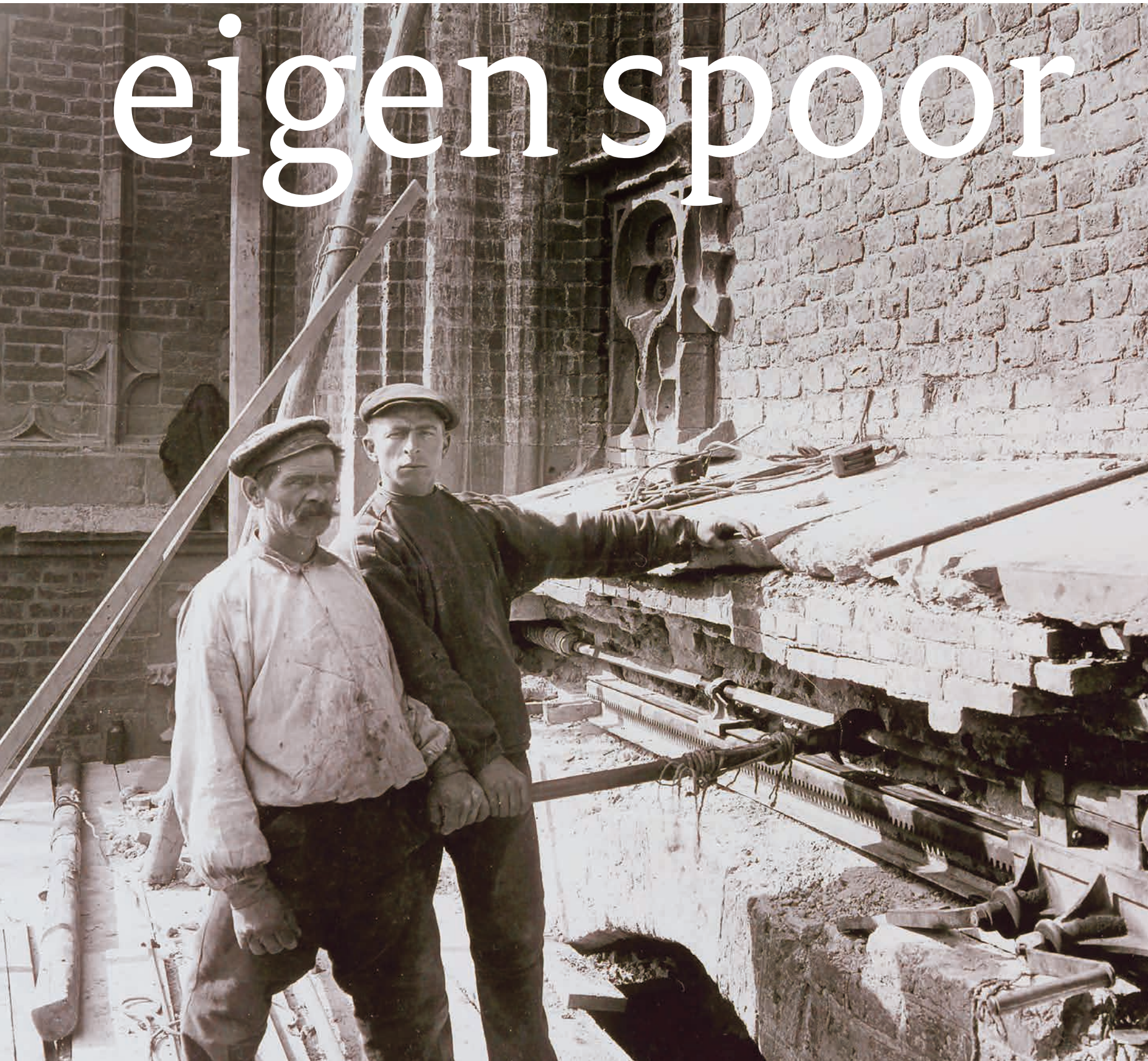
Honderd jaar geleden is de toren Oldehove in Leeuwarden, uit de zestiende eeuw, met beton gerestoreerd
