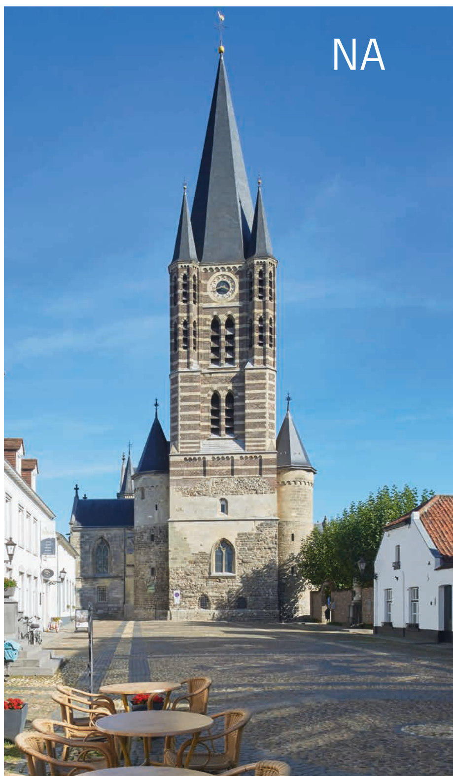
2018: De gevel is gerestaureerd met stenen van een afgebroken kerk
