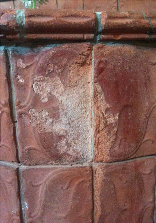
Via een afschilferende bovenlaag kan water het poreuze lichaam van het ornament bereiken
