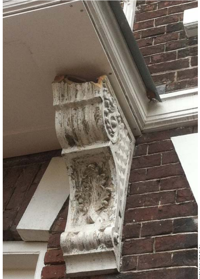
Bovenaan is een deel van deze console afgebroken
