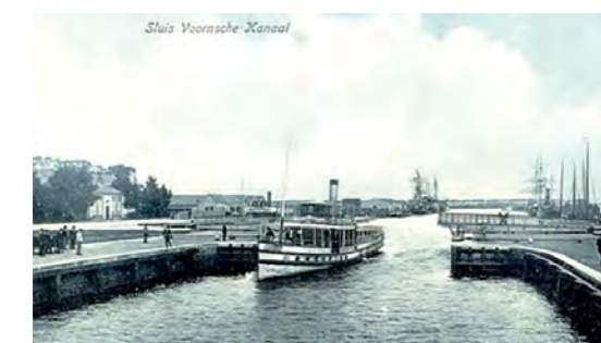
Sluis bij Hellevoetsluis in het Voornse Kanaal. Op de achtergrond liggen fregatten aan de kade. Bron: Streekarchief Voorne-Putten.
