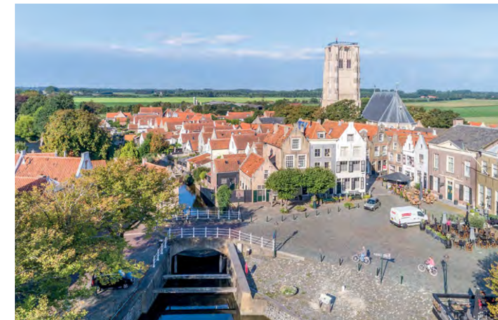
Haven van Goedereede. De deuren van de spuilsuis staan open. Erachter ligt de spuikom waarin met hoogtij water werd opgeslagen. De sluis wordt tegenwoordig niet meer als spuilsuis gebruikt. Bron: Jos Stöver, RCE.
