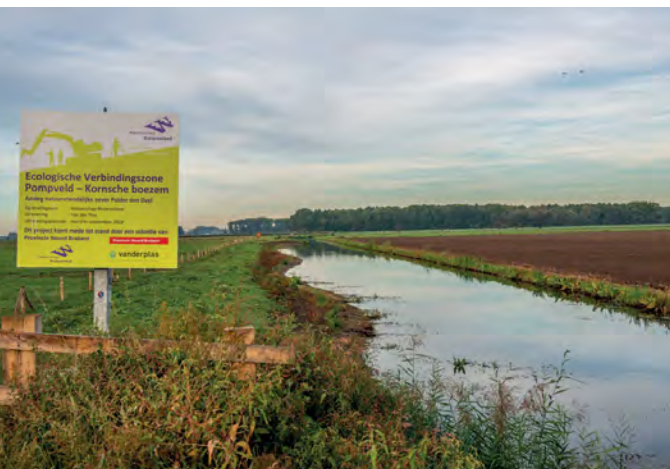
De Graaf in Land van Heusden en Altena. In 2018 is de zuidoever van de Graaf verflauwd om als ecologische verbindingzone te dienen. Foto Jos Stöver., RCE.
