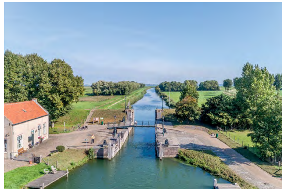
Havenkanaal van Dirksland vanaf het Dirkslandse Sas, in noordelijke richting gezien. De sluis werd gebouwd om de verzanding en verzilting van het binnenland tegen te gaan. Langs het kanaal lagen jaagpaden, waarover paarden de schepen voortrokken. Bron: Jos Stöver, RCE.
