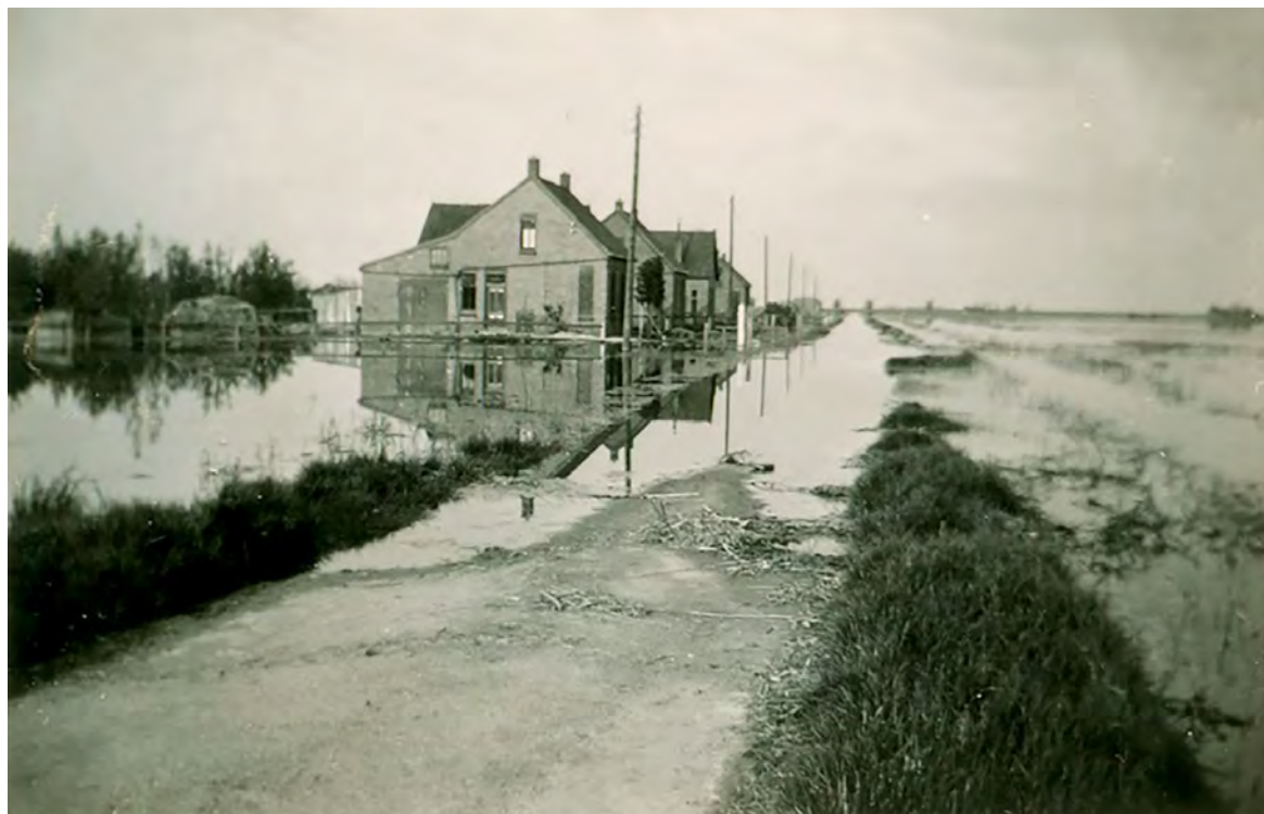
Inundatie in de Hoekse Waard (Oud-Piershilseweg van Nieuw-Beijerland naar Piershil in 1944). Bron: www.piershil.com .
