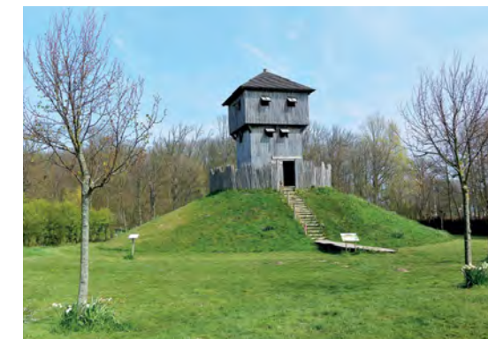
In Oostkapelle (Zeeland) staat een reconstructie van een motte omringd met gracht. Bron: John Pot.
