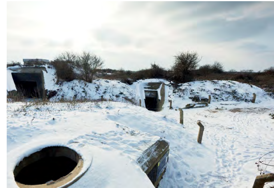
Het bunkercomplex 'De Punt', op het zuidoostelijke puntje van Goeree, nabij de Brouwersdam is toegankelijk gemaakt voor publiek.
