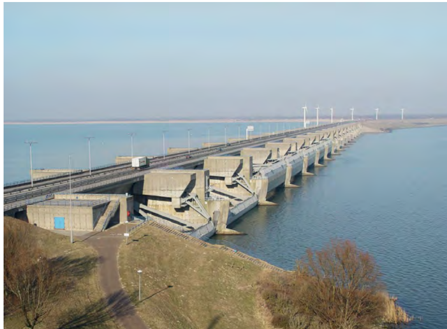
Haringvlietdam met een spuisluizencomplex van ongeveer een kilometer lang. Bron: Rijkswaterstaat
