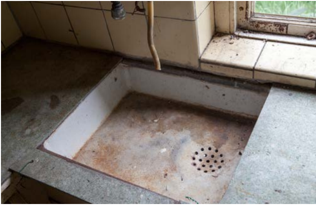
21. Gietijzeren aanrechtbak met een groen getint aanrechtblad van asbesthoudend materiaal in de keuken van de woning van de kampcommandant te Westerbork uit 1939; historisch hoog monumentaal, maar milieutechnisch moeilijk te handhaven
