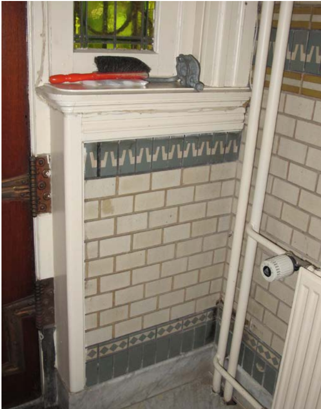
3. Witte baksteen toegepast aan het in 1908 gereed gekomen landhuis Oud Groevenbeek te Ermelo. De gele bakstenen met een patroon zijn zogeheten bricorna -stenen (een samentrekking van Brique en ornata ) in 1906 geïntroduceerd door de baksteenfabrikant Van de Loo uit Dieren (foto MAB F. Haans, 2011)
