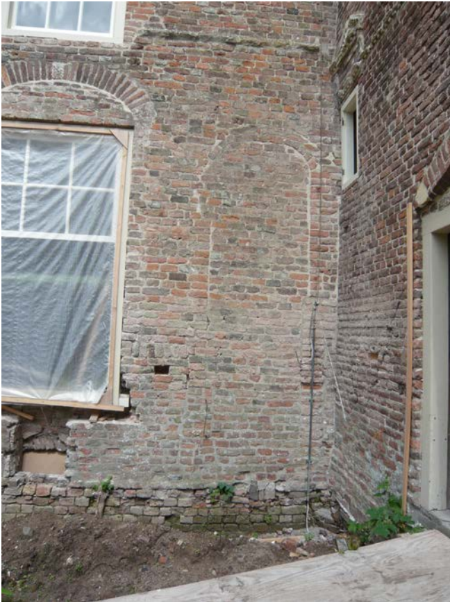
2a. Detail van de zuidgevel van de middenvleugel van kasteel Waardenburg tijdens restauratie in 2008 met sporen van dichtgezette openingen (foto A. Viersen, 2008)
