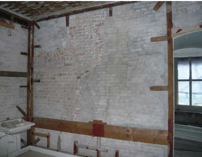
14a/b Ruimte o.17 in kasteel Waardenburg tijdens de restauratie in 2008 met een muur ontdaan van zijn bespanning en een tekening van gevonden bouwsporen (foto/tekening A. Viersen, 2008)
