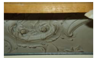
11a/b Ruimte met schouw in het voormalige Hervormd Burgerweeshuis Voorhaven 57 te Delfshaven gemeente Rotterdam met een detail van het boven het verlaagde plafond aanwezige achttiende-eeuwse stucplafond (foto rs)
