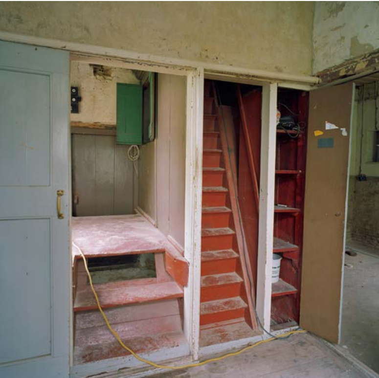
Een waardevolle structuur: vanuit een hoge kamer is een kleine opkamer bereikbaar, net als een steile trap naar de verdieping en een smalle kast
