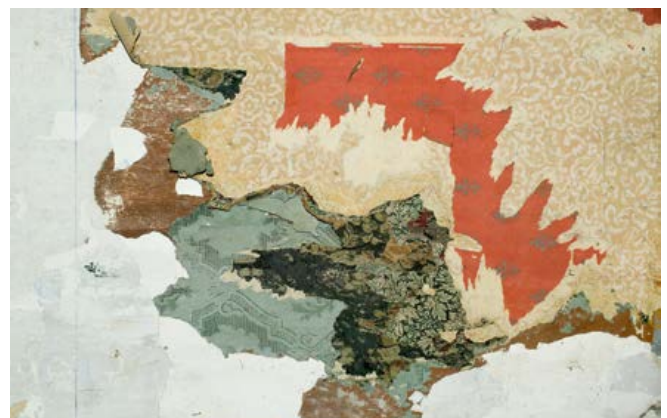
Behanglagen zijn in de loop der tijd over elkaar aangebracht. Onderzoek kan hun ouderdom bepalen
