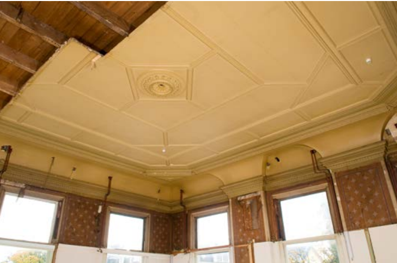
Achter voorzetwandjes en een verlaagd plafond komen de oorspronkelijke wandafwerking en een stucplafond tevoorschijn
