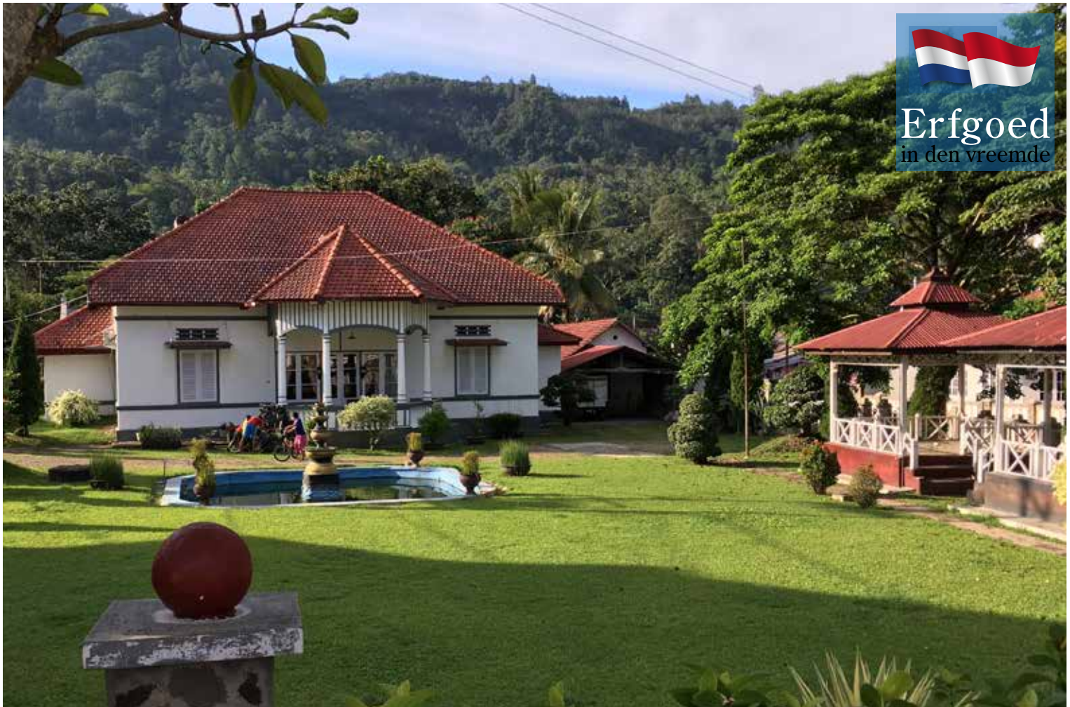
VOORMALIGE DIRECTIEVILLA, NU GUEST HOUSE.
