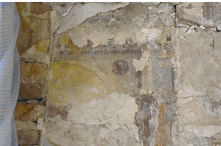
Achter weggebroken stucwerk verschijnt een muurschildering
