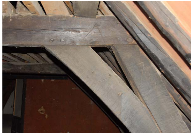
Telmerken op een houten dakconstructie
