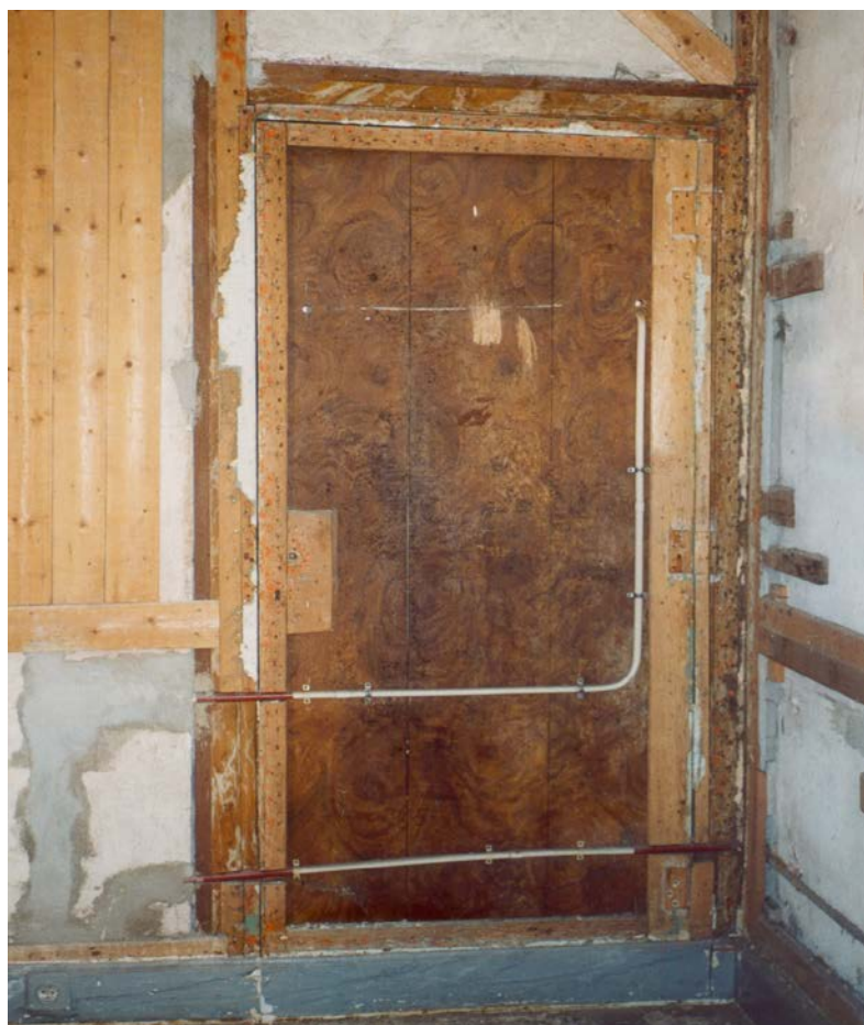
Een bouwhistorische vondst: achter een voorzetwand bleek een deur uit de zeventiende eeuw schuil te gaan
