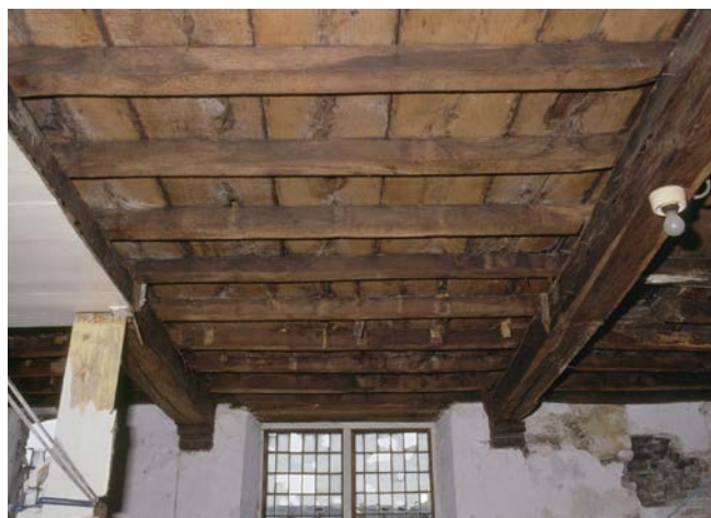
De oude verdiepingsvloer komt weer in het zicht
