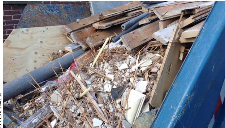
De restanten van een stucplafond op riet in een afvalcontainer
