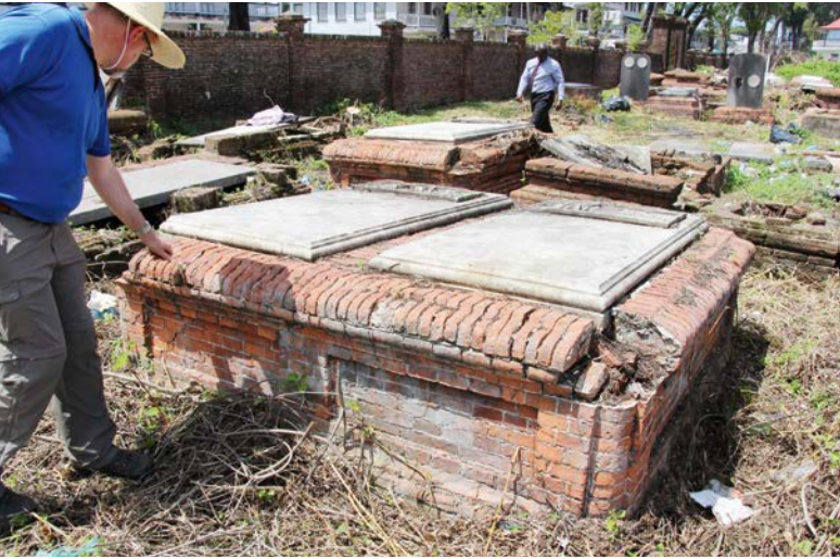
De spaarzaam gemetselde grafmonumenten zijn vaak behoorlijk beschadigd
