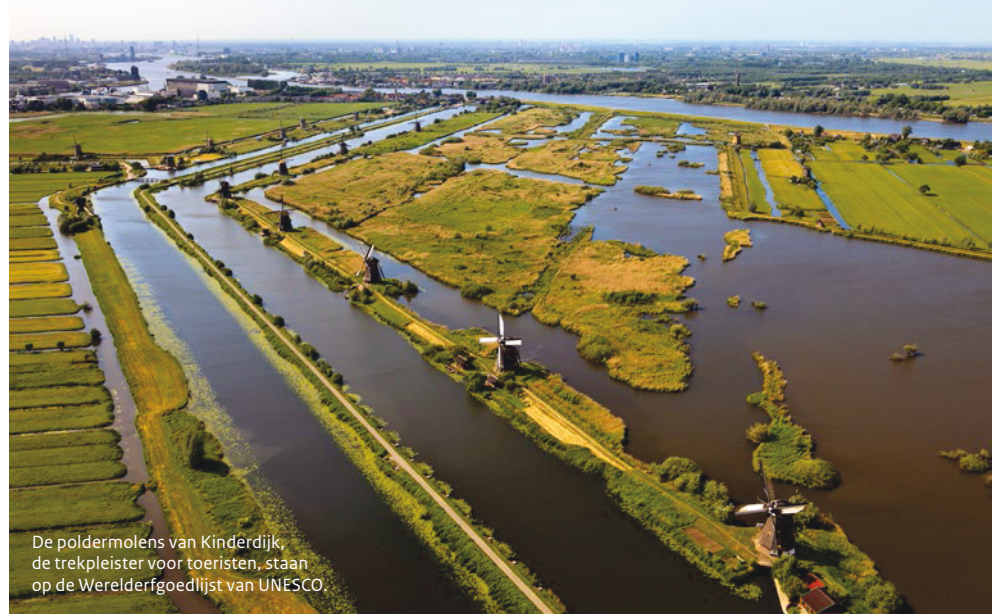
Rijksmonument Haringvlietsluizen en Haringvlietdam, zesde werk van de Deltawerken, verbindt met de N57 Voorne-Putten en Godree-Overflakkee.
