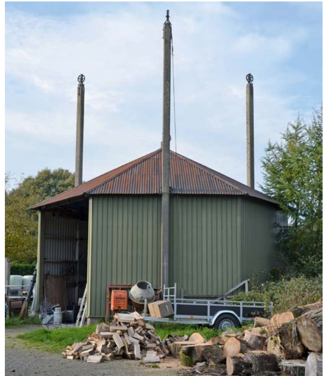
Deze moderne hooiberg is dichtgemaakt met stalen damwandplaten om hem als schuur te kunnen gebruiken
