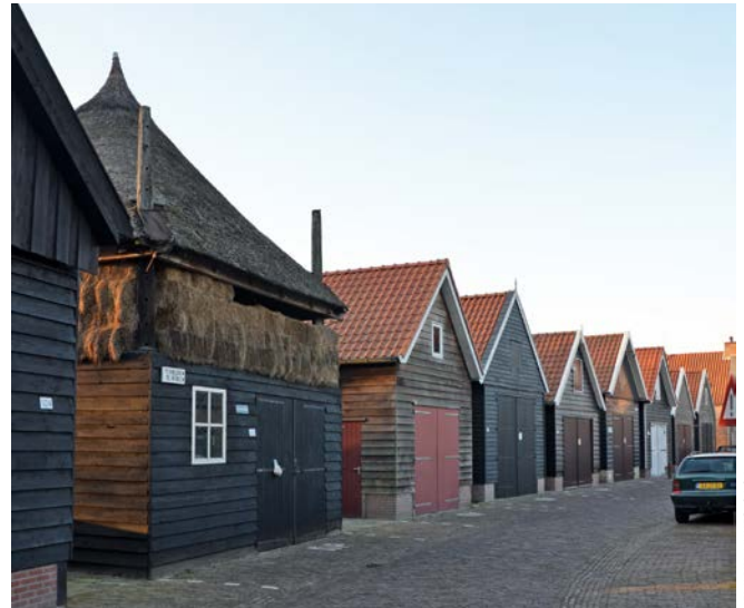
Aan de Achterweg in Genemuiden staat een rij met hout afgedichte hooibergen
