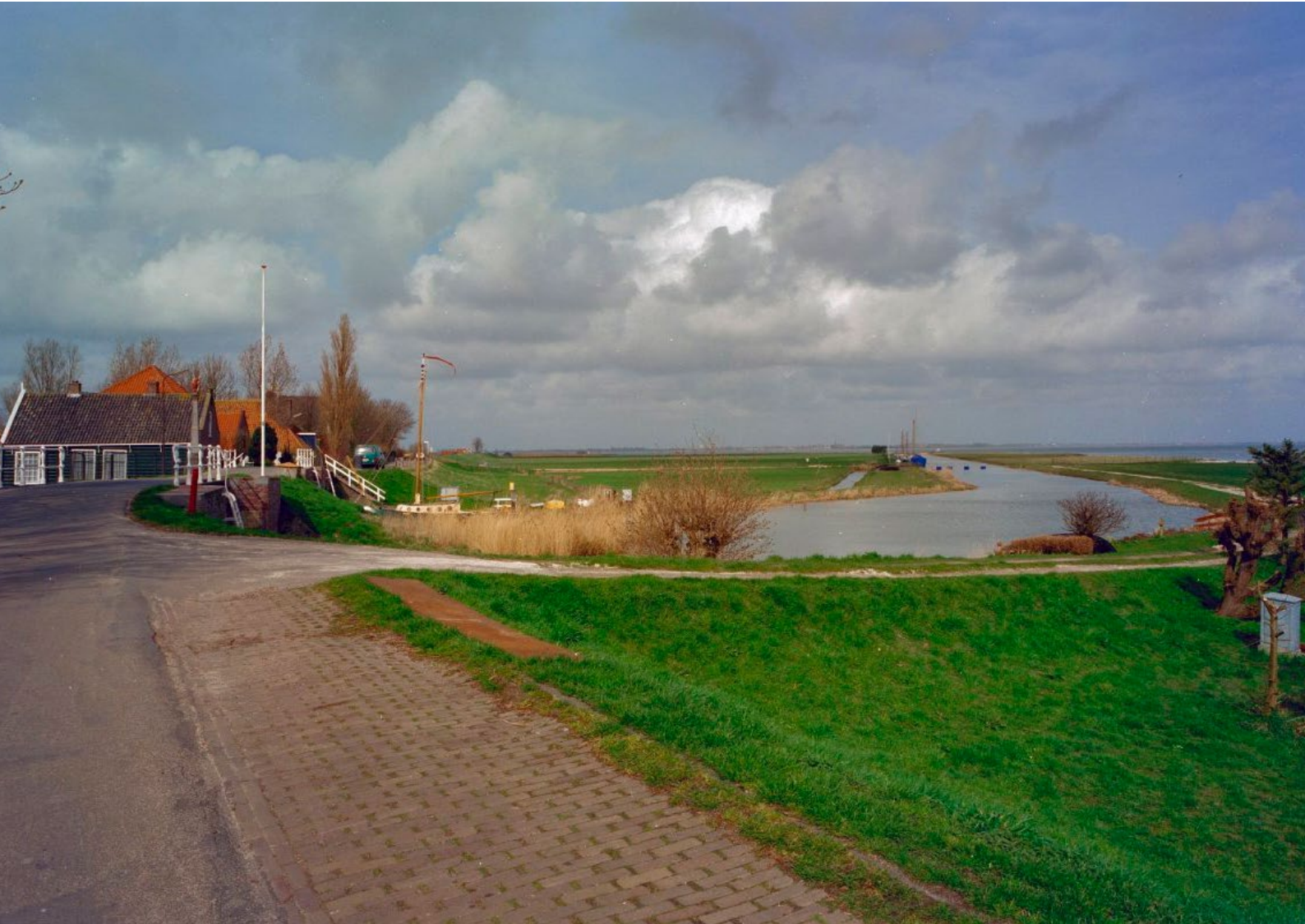
Sluis in Schardam met uitwatering aan de zeezijde.
