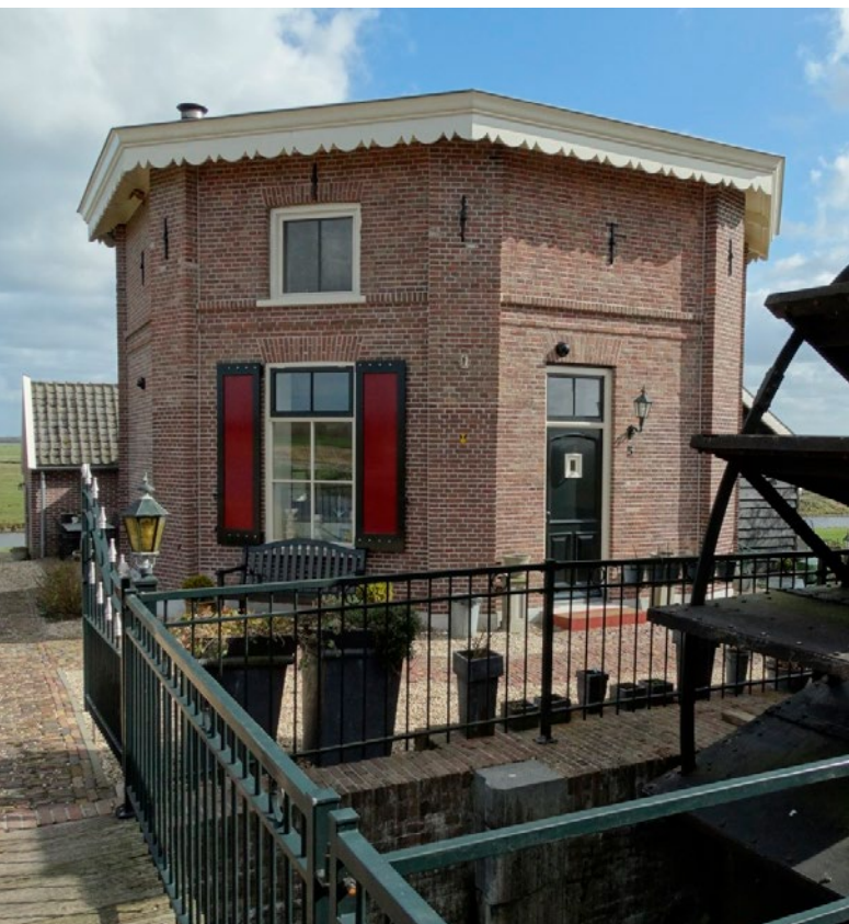
Polder Arkemheen, Nijkerk. Machinistenwoning bij het stoomgemaal Arkemheen, ondergebracht in het achthoekige, bakstenen ondergedeelte van de voormalige poldermolen Hertog Reynout uit 1860.
