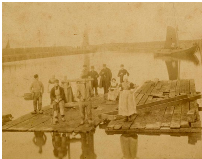
De nieuwe haven van Spakenburg in aanbouw. Foto uit 1886.
