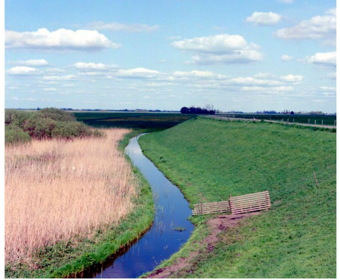
Zuiderzeedijk bij Elburg (situatie 1984).
