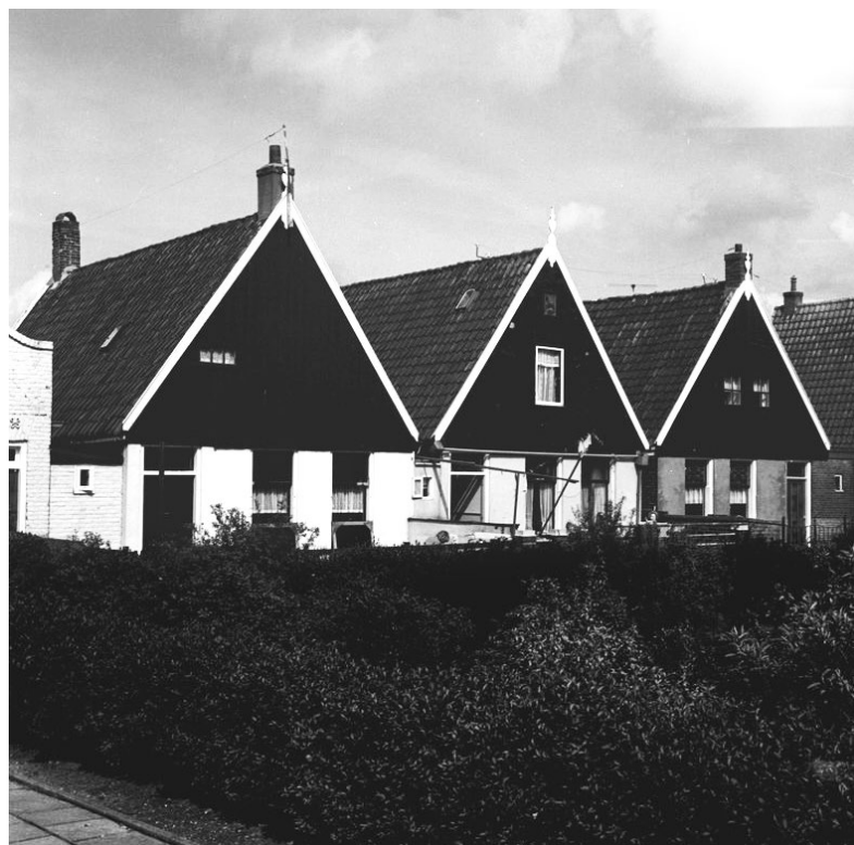
Moderne visserswoningen in Urk, 1960-1970.
