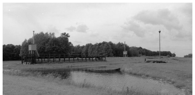
Het gereconstrueerde havenhoofd van Kuinre.
