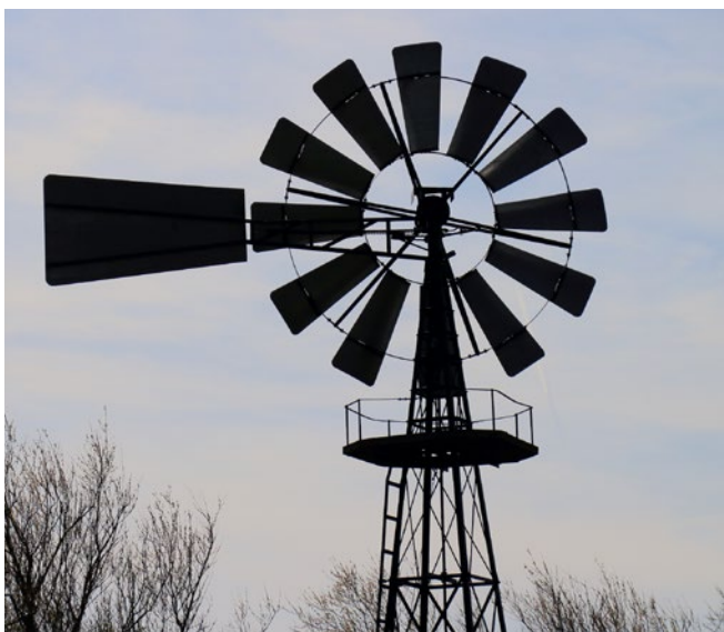
Amerikaanse windmolen aan de Wieldijk bij Mirns. De molen werd na de afsluiting van de Zuiderzee gebouwd voor de bemaling van een buitendijkse zomerpolder.
