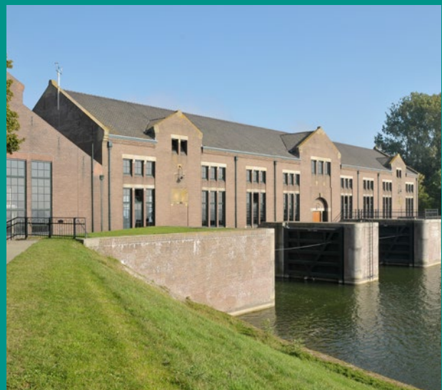
Het Ir. D.F. Woudagemaal te Lemmer.
