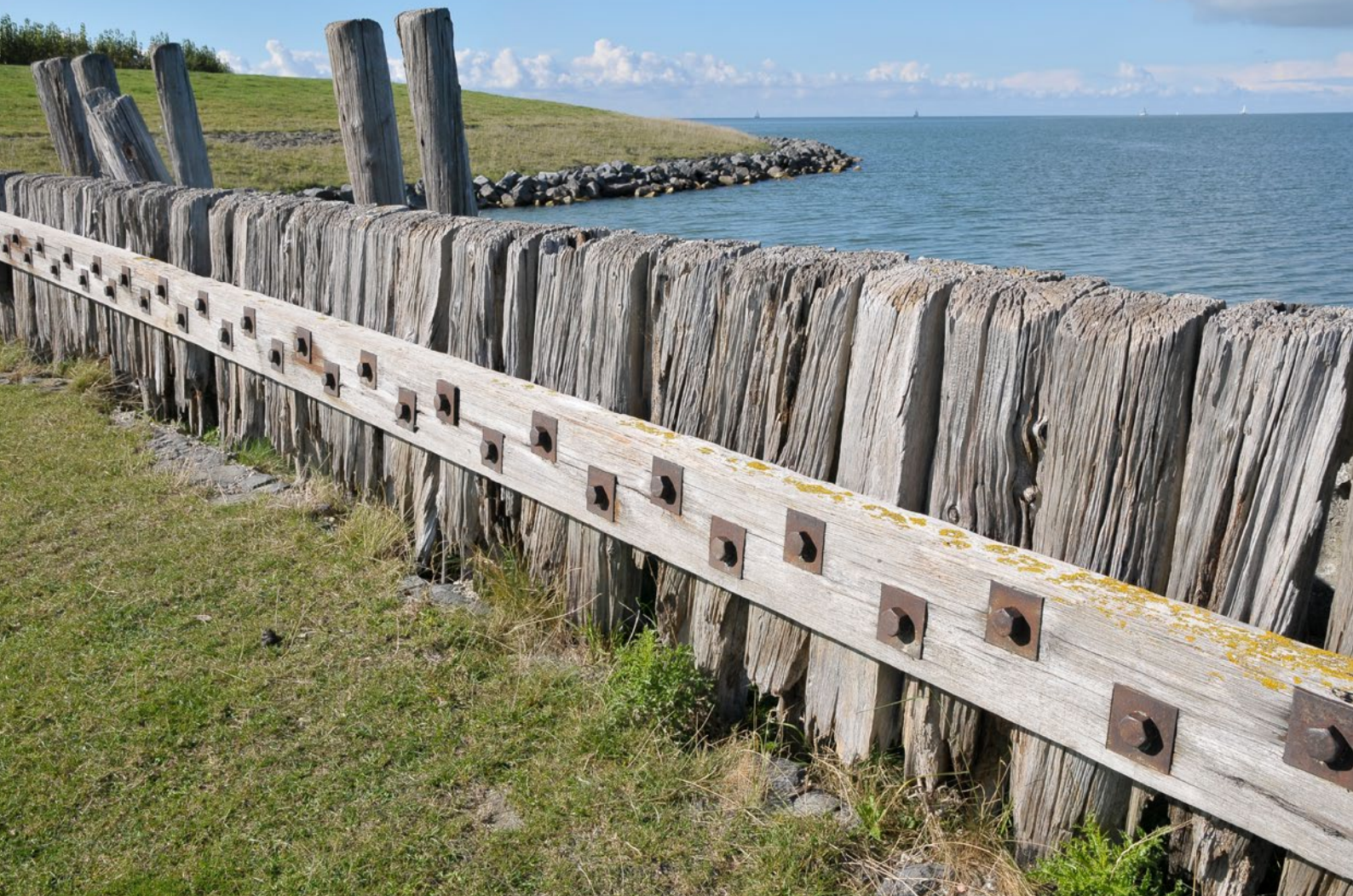
Paalwerk langs de voormalige buitengeul van de Molkwerumerzijl.
