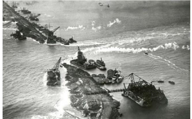
Werkzaamheden aan de Afsluitdijk, twee dagen voor de dichting op 28 mei 1932.
