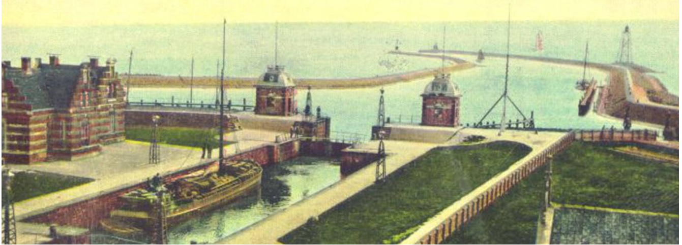
Ansichtkaart van de in 1888 aangelegde havenwerken en zeesluis in Lemmer.
