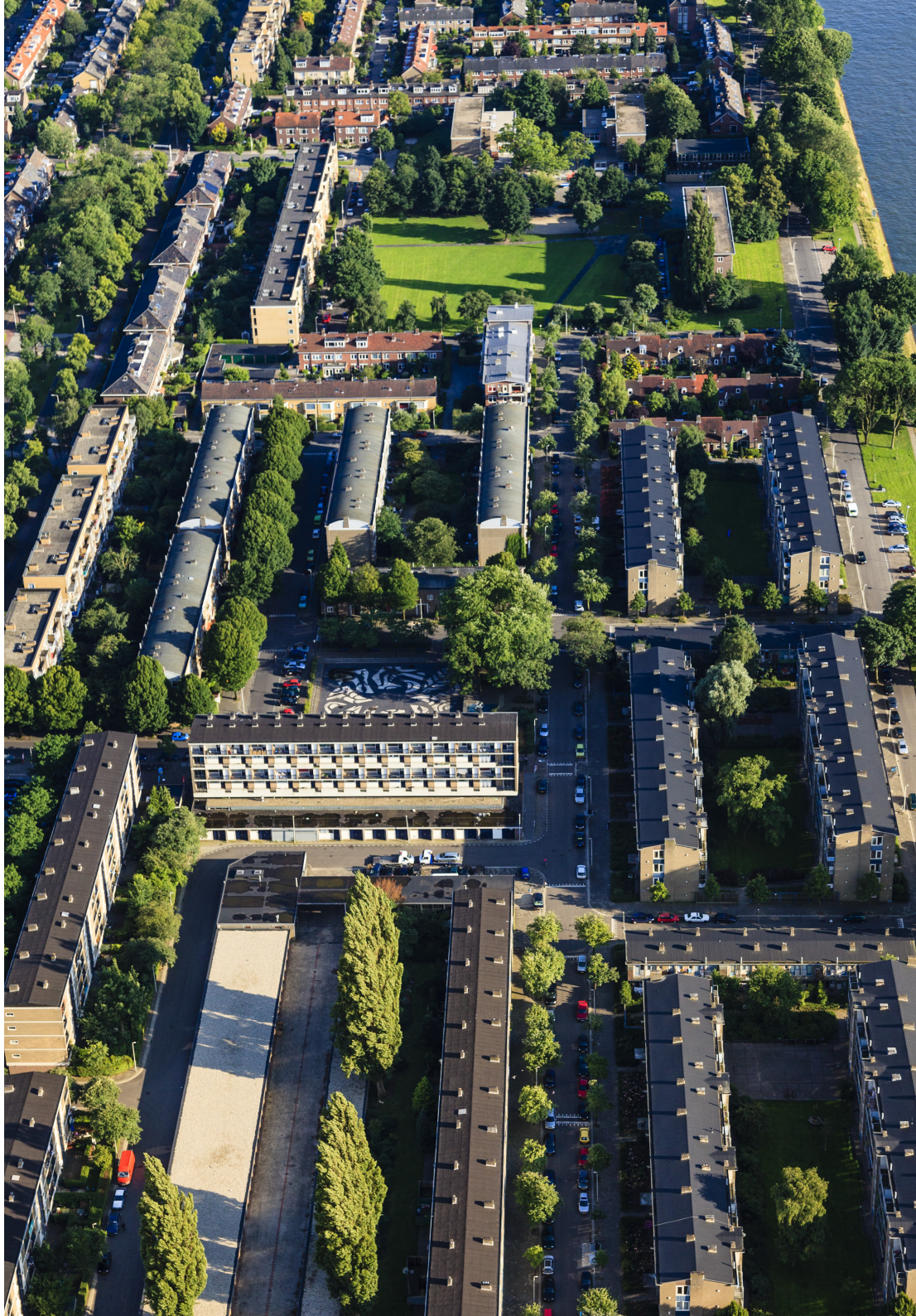
Open bouwblokken in het noordelijke deel. Foto: Rijksdienst voor het Cultureel Erfgoed, Siebe Swart.
