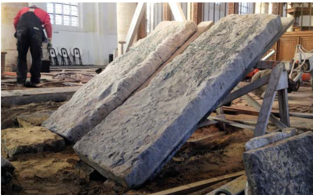
De gebroken grafzerken zijn aan de onderkant met staal gewapend
