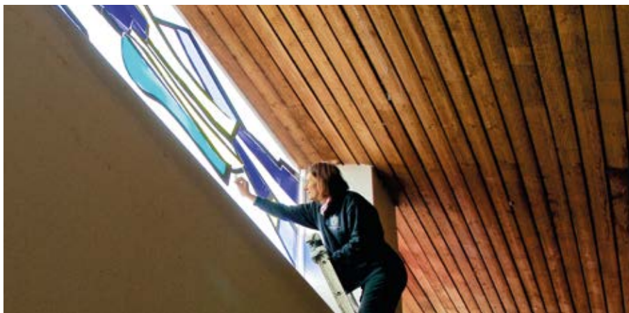
De teruggeplaatste ramen worden schoongemaakt
