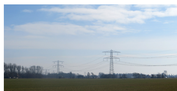
hoogspanningslijn door Haskerveenpolder
