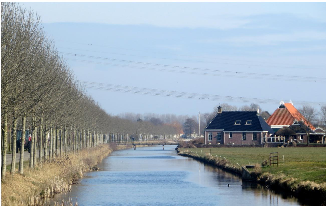
Hoofdwatergang langs de Meenscharweg, met betonnen plaatbruggen naar de Wederopbouwboerderijen
