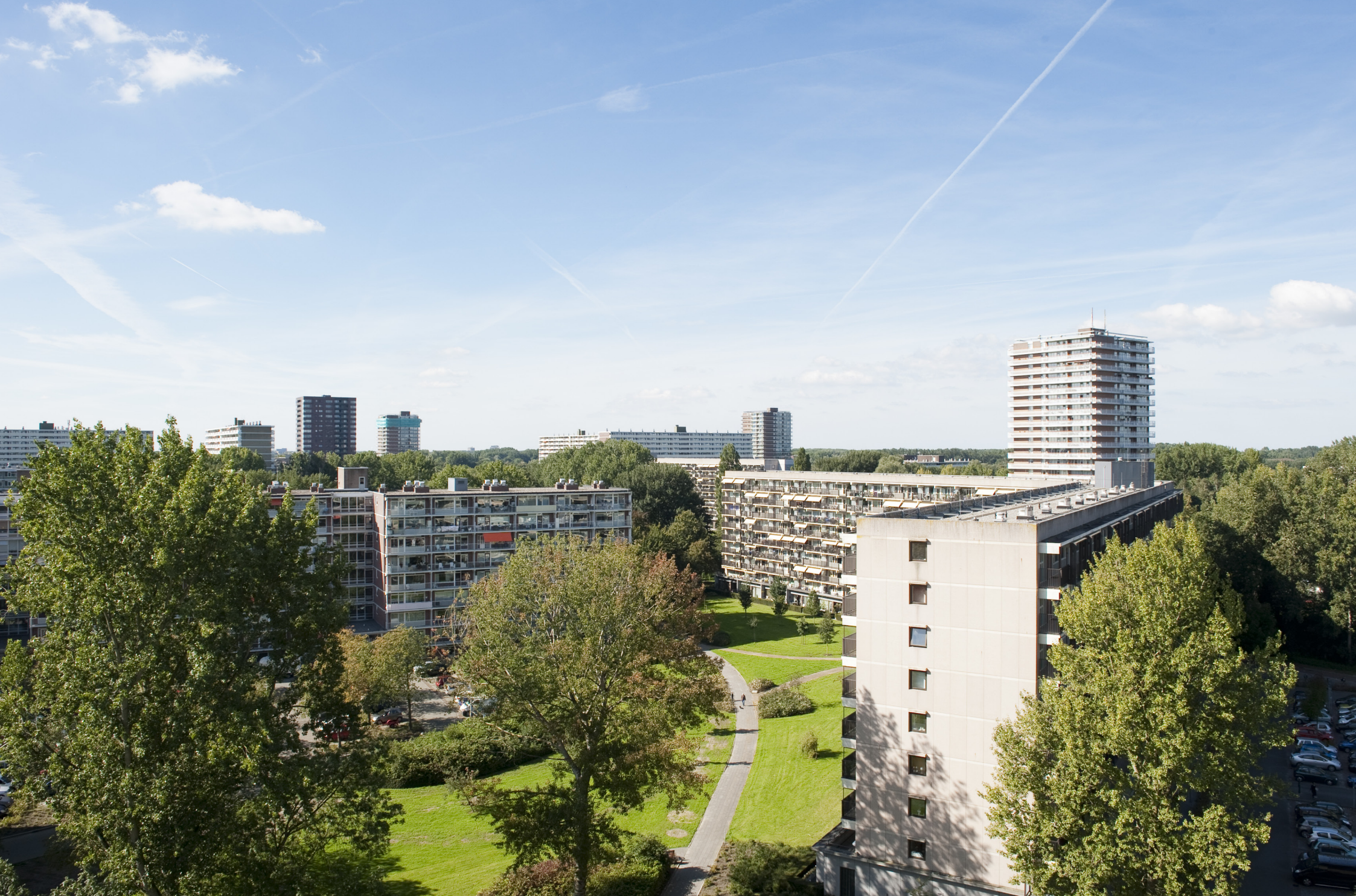
Orientatie van balkons op de zon en parkeervlakken consequent aan de schaduwzijde. Foto: Nadine van den Berg.
