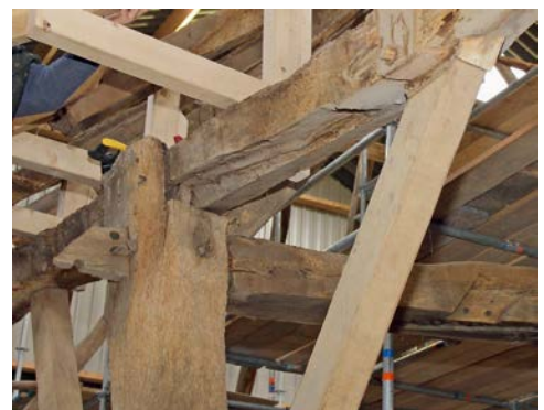
Afb. 6.14 De bovenste ankerbalk in gebint 4 is een hergebruikte koppelbalk van het langsgebint. Het uiteinde van de balk steekt door de stijl en is van boven afgeschuind. Ook zijn er gaten van toognagels aanwezig waarmee een dakspoor was bevestigd. Rechts op de foto een 'loze' keep van een lipverbinding (foto R. van Nooijen).
