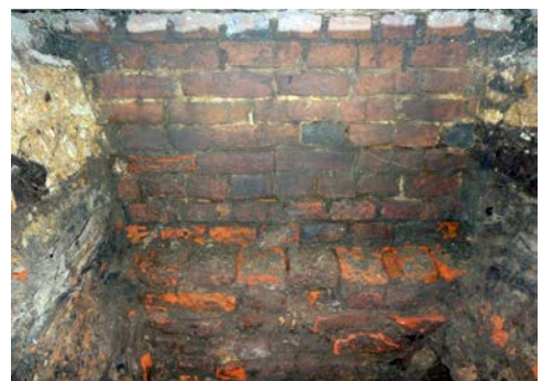
Afb. 5.25 Werkput 6, westprofiel. Vanaf twee steenlagen boven de vertanding verandert de baksteensoort.
