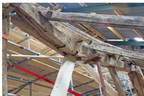
Afb. 7.5 De gebroken gebintplaat aan de westzijde (foto R. van Nooijen).
