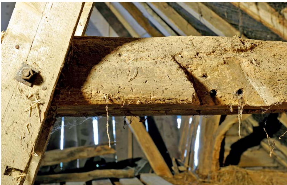
Afb. 6.11 Een loze inkeping voor een lipverbinding in de bovenste ankerbalk van gebint 2 (foto M. Wasmus).
