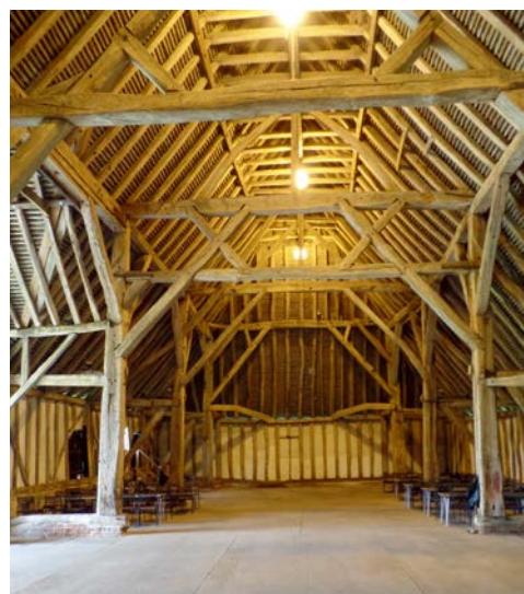
Afb. 6.8 'Barley Barn', Cressing Temple (Essex, GB; gebouwd kort voor 1235). Het oudst bekende voorbeeld van een langsgebint. De schoren tussen stijl en koppelbalk zijn met lipverbindingen bevestigd. (foto D.J.K. Zweers).
