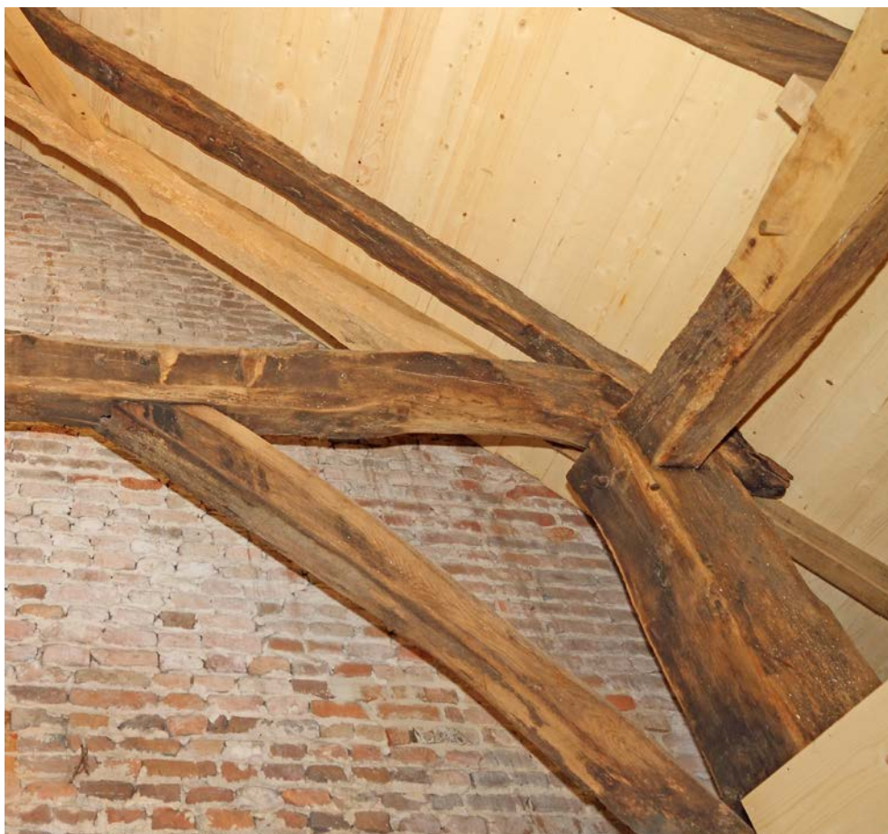
Afb. 6.5 Ontmoeting tussen gebintplaat, stijl en koppelbalk van gebint 1 aan de westzijde. De gebintplaat ligt in een keep aan de bovenkant van de stijl (detail 1 in afbeelding 6.2). Daarbovenop een dwarsbalk, waarop een dakspoor is bevestigd. Rechts is de langsgerichte las te zien (detail 3 in afbeelding 6.2).
