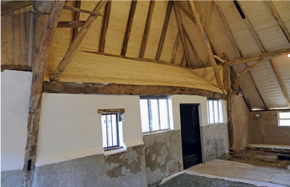
Afb. 6.20 Gebint 5 is onderdeel van de noordelijke eindgevel van de boerderij. Boven de ankerbalk het gerestaureerde schuuroverstek (foto R. van Nooijen).
