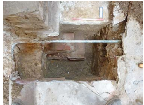
Afb. 5.21 Werkput 5. De fundering van de gebintstijl gezien vanuit het zuiden.
