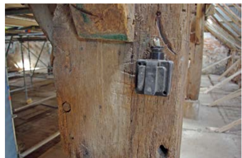
Afb. 6.18 Gesneden telmerk VIII (acht) op de zuidkant van de oostelijke stijl van gebint 2.
