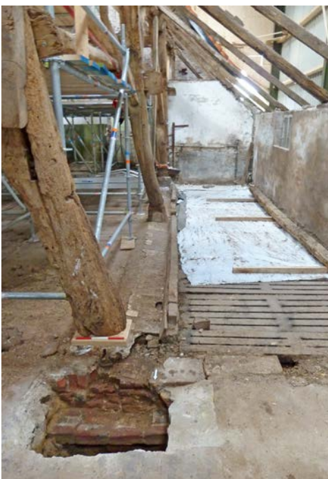
Afb. 5.12 Ligging van werkput 3, gezien vanuit het noorden.
