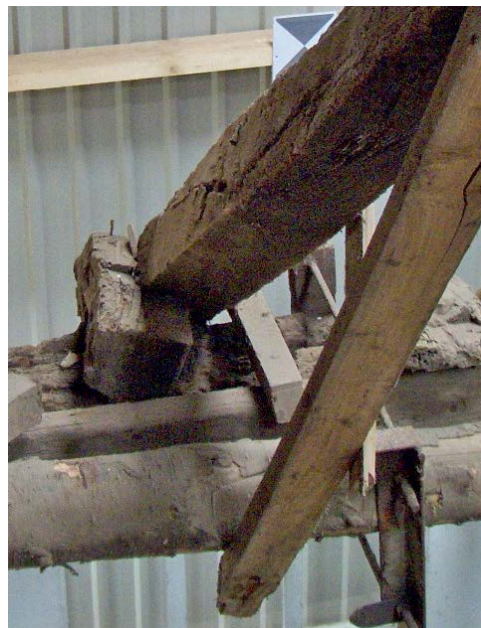
Afb. 7.6 Eén van de vier in situ bewaarde daksporen met blokkeel uit 1263.
