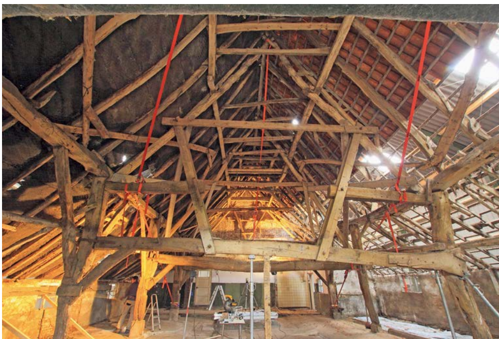
Afb. 7.4 Gebint 4 tijdens de restauratie. De bovenste gebintbalk is doorgezaagd om makkelijker over de zolder te kunnen lopen (foto R. van Nooijen).
