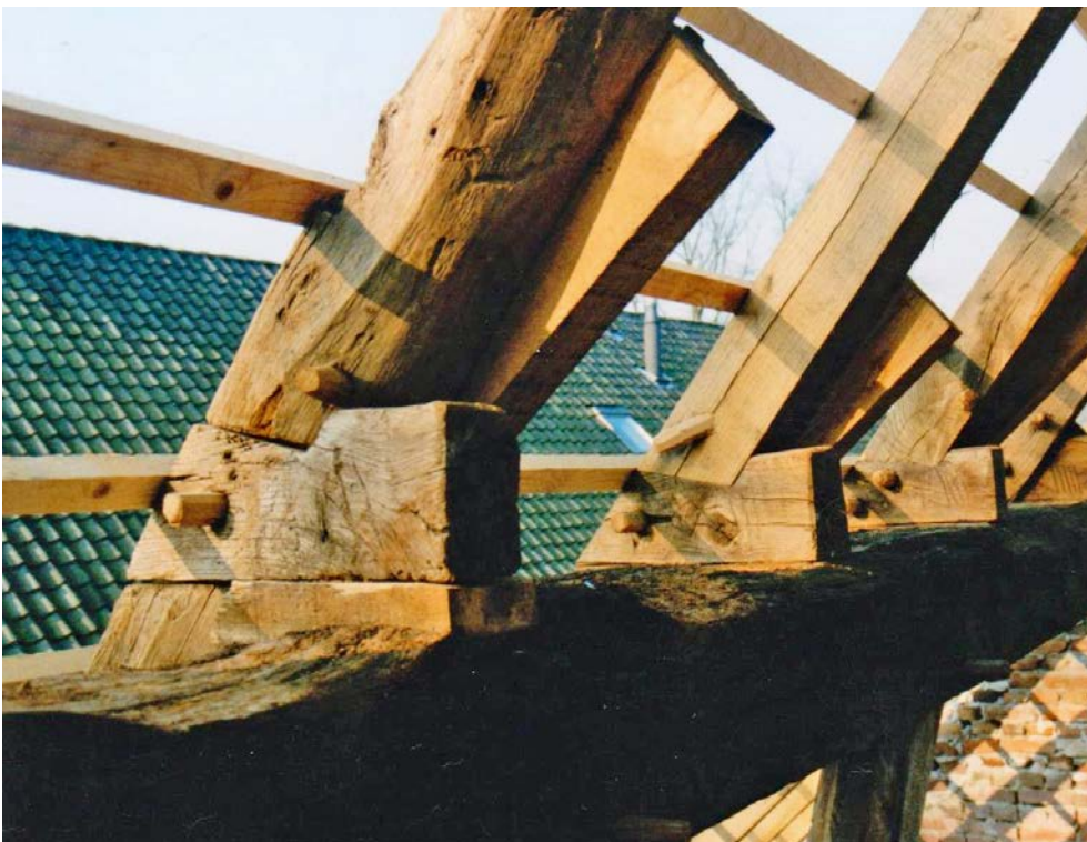
Afb. 6.13 Bevestiging van de daksporen met blokkeels in Vessem (foto H. Strijbos).
