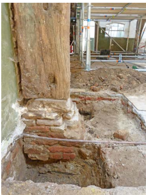
Afb. 5.11 Werkput 2, westprofiel (vlak 104B). Foto van de oostelijke poer en de brandmuur. De poer staat koud tegen de brandmuur en is slechts enkele decimeters hoog. Onder de poer ligt een gedeelte van een lemen vloer, die doorsneden wordt door de funderingsleuf van de brandmuur.
