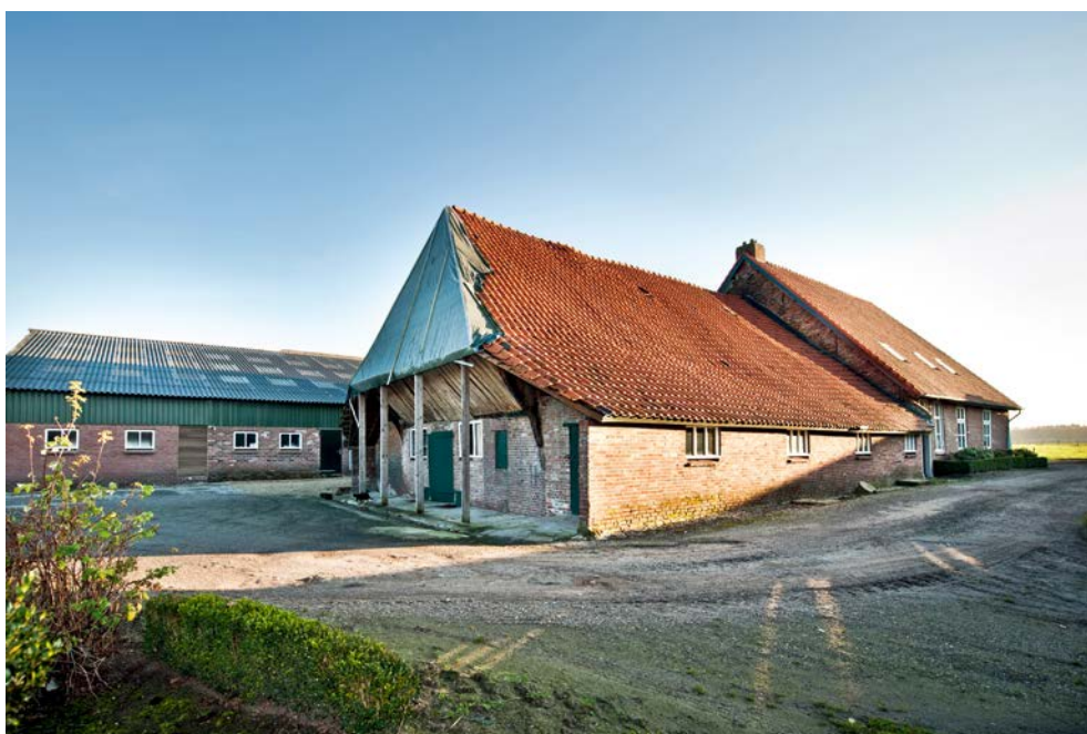
Afb. 7.1 De hoeve voor de restauratie in november 2011. De overstek wordt gestut en in het dak is sprake van een diepe zonk (foto M. Wasmus).
