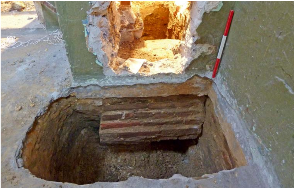
Afb. 5.19 Werkput 4. De poer onder de koof, gezien vanuit het westen.
