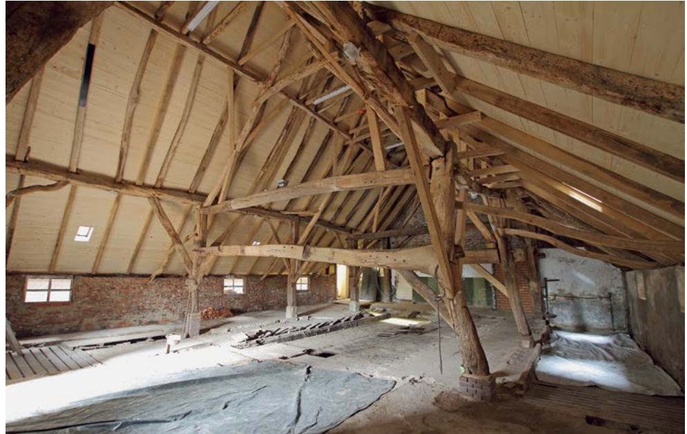
Afb. 6.17 De gebinten 4, 3 en 2 gezien vanuit het noorden. Foto genomen tijdens de restauratie. (foto R. van Nooijen).
