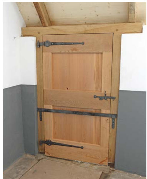
Afb. 7.7 Deur aan de westzijde van de voorstal. Kopie van de oude deur met ambachtelijk smeedwerk (foto R. van Nooijen).
