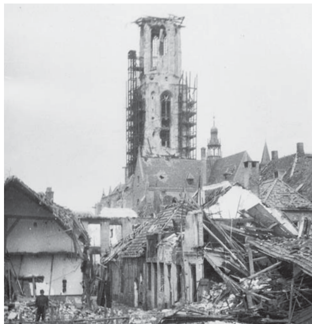
De Cunerakerk in 1945, de toren beschadigd door de beschietingen.
