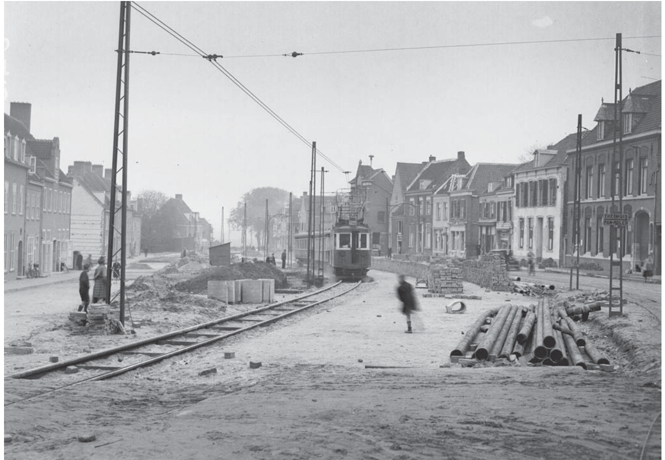
Frederik van de Paltshof/Herenstraat in aanbouw in 1947: een verkeersweg en verblijfsruimte gecombineerd, geïnspireerd op de Zutpense Groenmarkt.
