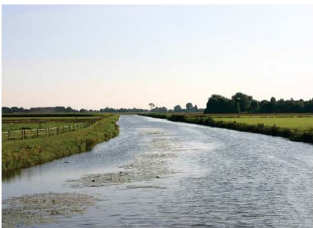
De Grote Wetering, het nieuw gegraven deel ter hoogte van de Nieuwstraat
