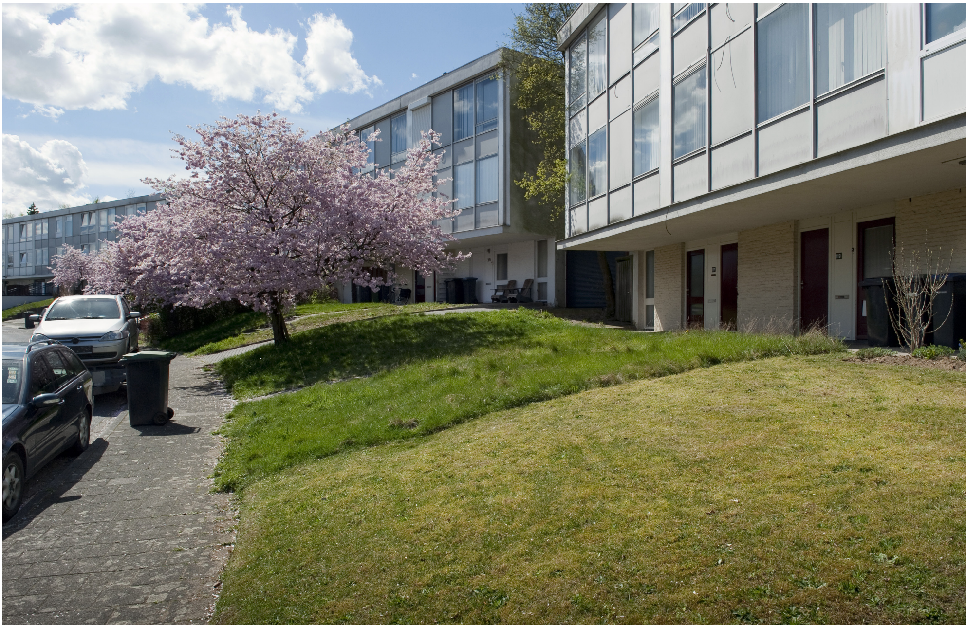
In de oorspronkelijke opzet werd aan de straatzijde het hoogteverschil opgevangen met grasbermen met daarin paadjes naar de woningen en een voetpad op de rooilijn van het uitkragende deel. Foto: Nadine van den Berg.
