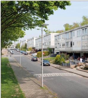
Getrapte bouwblokken parallel aan de weg
