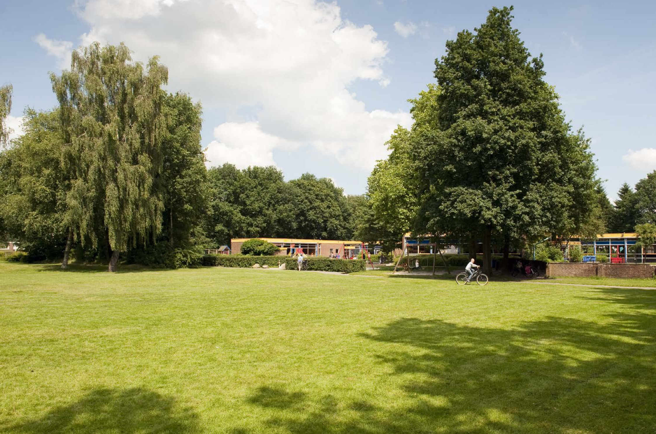
Basisschool Kristalla – een ontwerp van de Emmense architect Cees Groen – ligt ingebed in de groenzone tussen de wijken Angelslo en Emmerhout. Foto: Nadine van den Berg.
