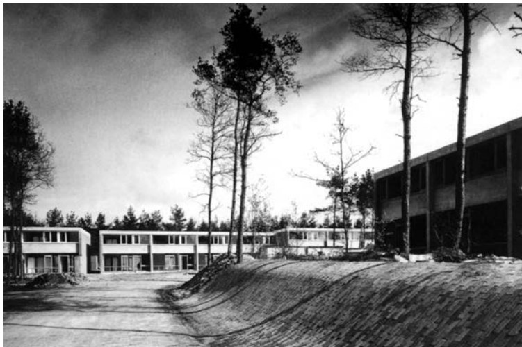
De eerste woonerven net na aanleg: Links het erf aan de Laan van de Eekharst (met oude bomen en reliëf), rechts een erf met drive-inwoningen in het noordelijke deel. Bron: Gemeentearchief Emmen.
