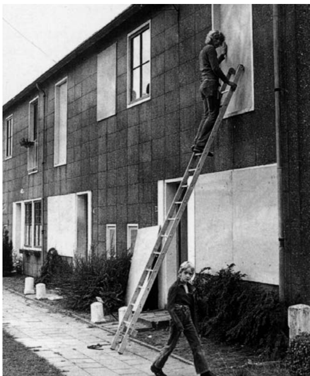
De inmiddels gesloopte Airey-woningen bestonden uit een stalen constructie met betonplaten. Bron: Gemeentearchief Emmen.
