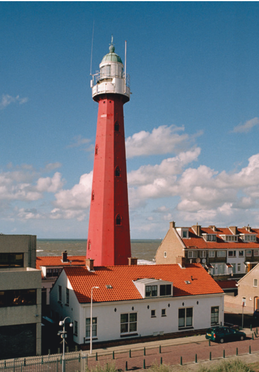
De rijksmonumentale vuurtoren van Scheveningen is in 1875 uit gietijzer opgetrokken en functioneert nog steeds
