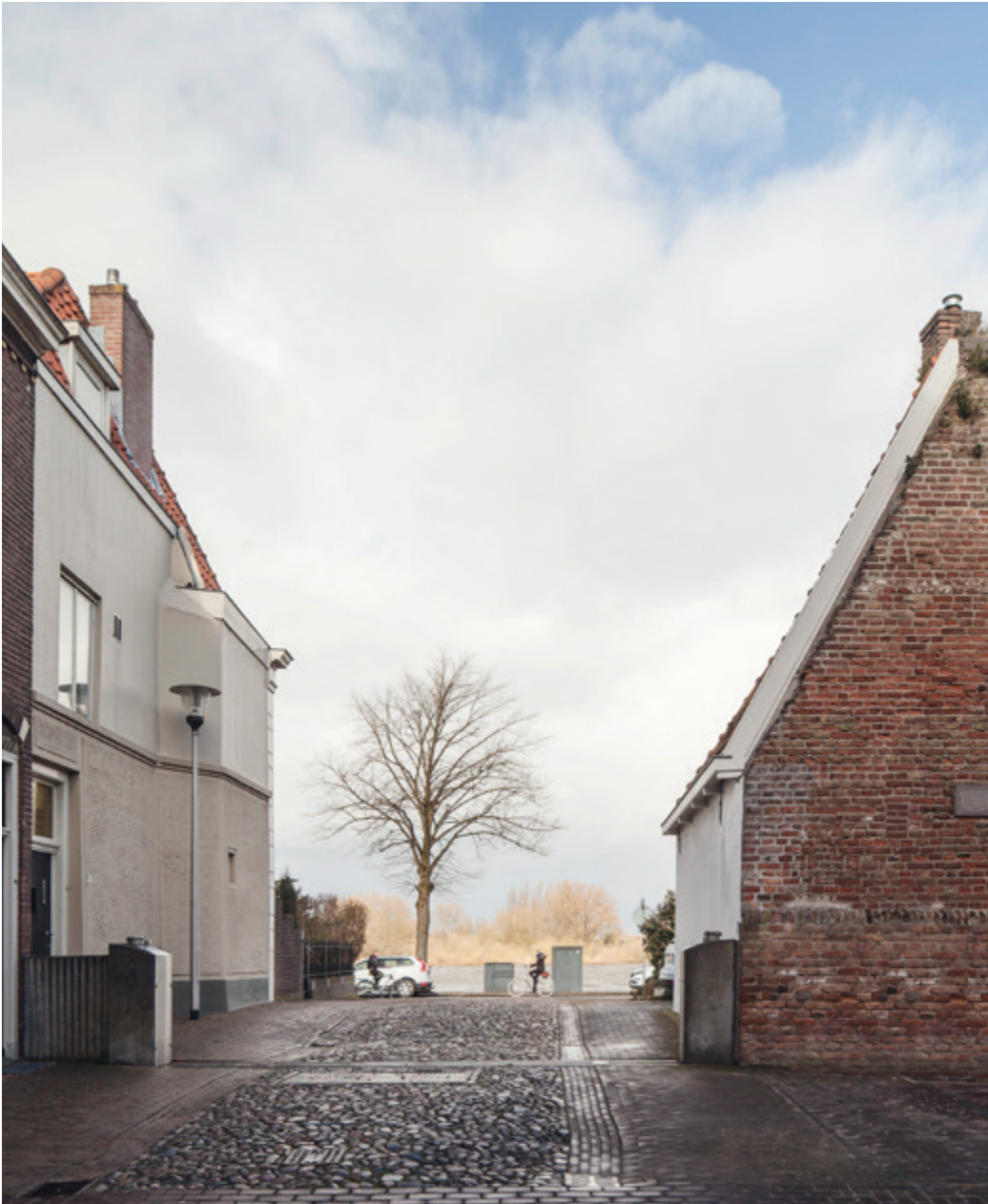
In Kampen is de middeleeuwse stadsmuur als vanouds ingezet als waterkering. Hier de hefschuifkering in de Meerminnenpoort in ruststand
