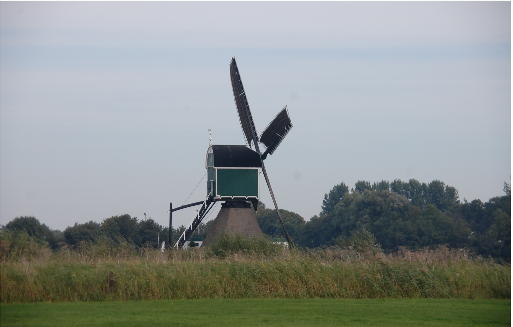
Uitwateringsmolen in de Oude Hollandse Waterlinie
