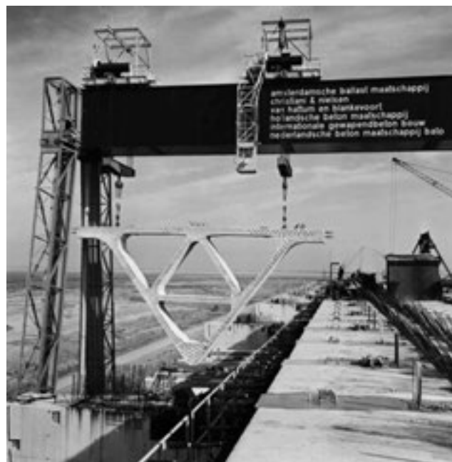
plaatsing NABLA ligger [RWS]
