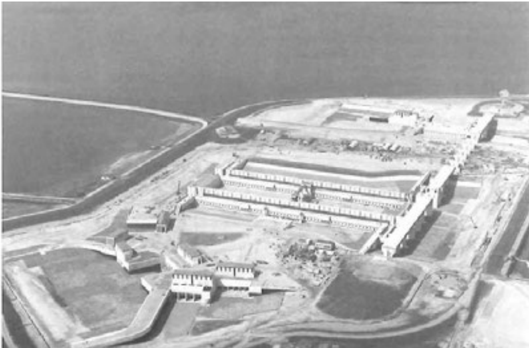
de bouwput van de Krammersluizen vóór de inundatie, 1983 [Deltaberichten]
