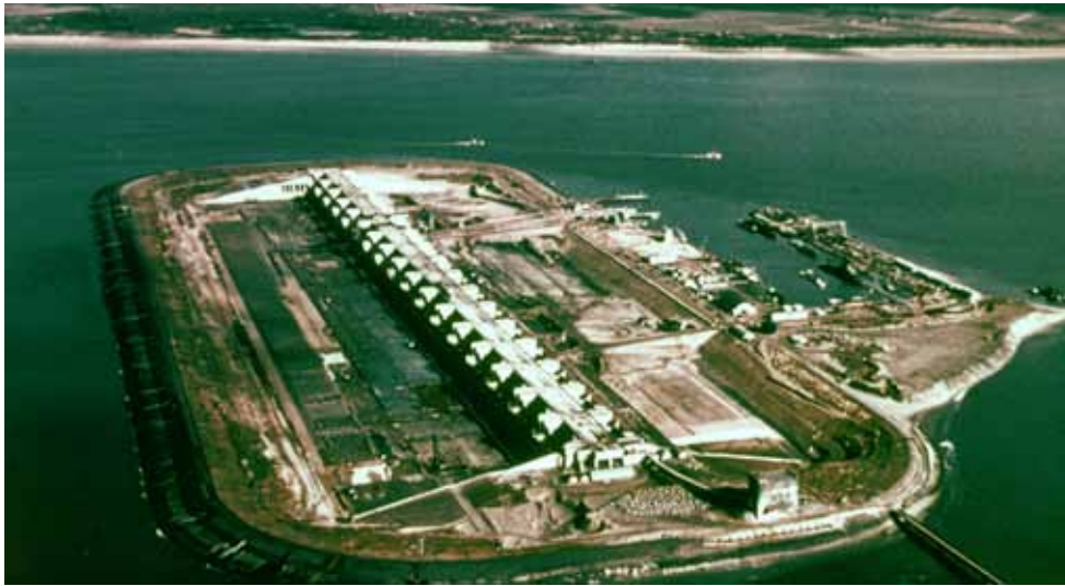
bouwput en werkeiland van de spuisluizen in Haringvliet [RWS]
