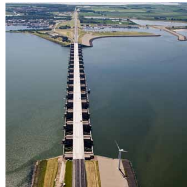
spuisluizencomplex met op de achtergrond de Goereese zijde van de dam [RWS]
