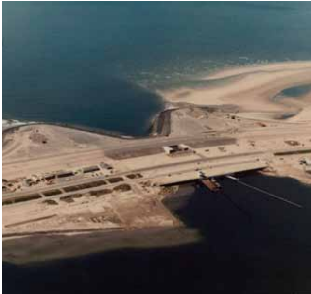
doorlaatsluis bij het zuidelijk sluitgat [RWS]
