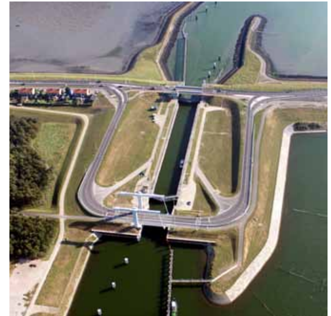
sluis met nieuwe weg en brug [RWS]
