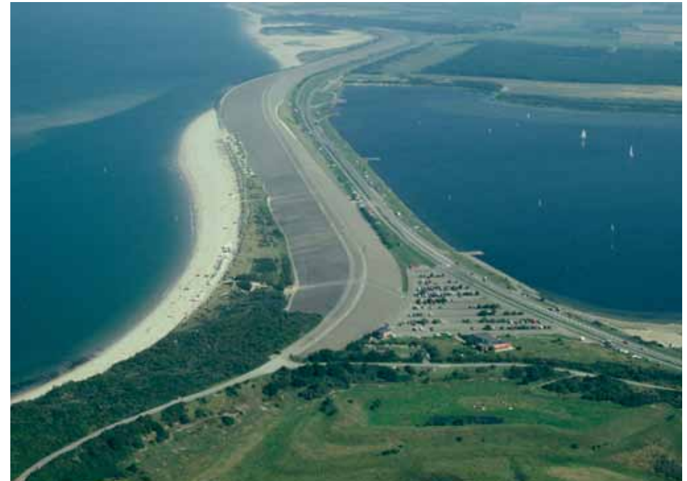
de dam voordat deze bekleed werd met zand, op de achtergrond (rechts) de bossen op de Plaat van Onrust naar het ontwerp van Staatsbosheer [RWS]
