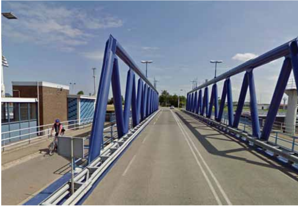
beweegbare brug bij de Westsluis met links het blauw betegelde bedieningsgebouw
