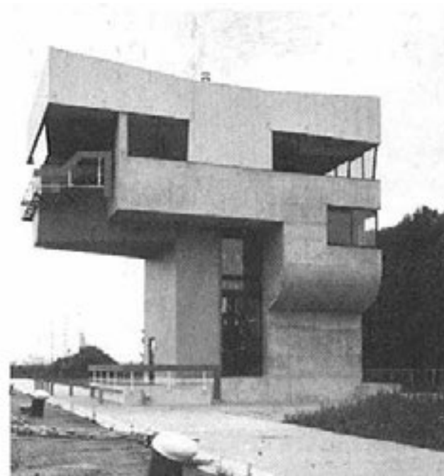
bedieningsgebouw Middensluis [RWS]
