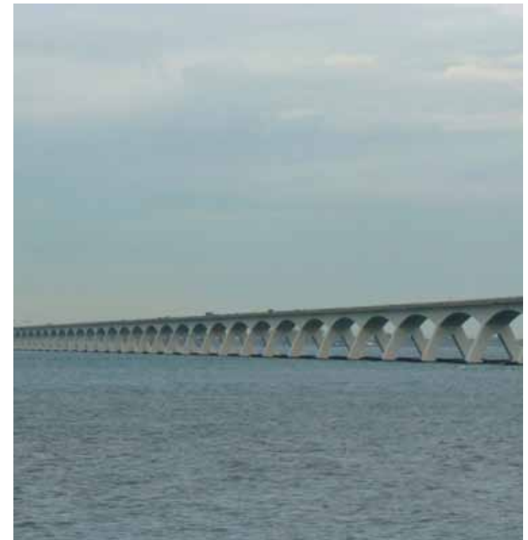
huidige staat van de brug
