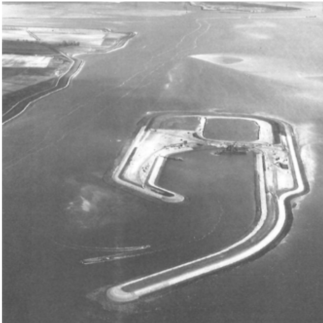
Bergse Diepsluis in aanbouw [RWS]
