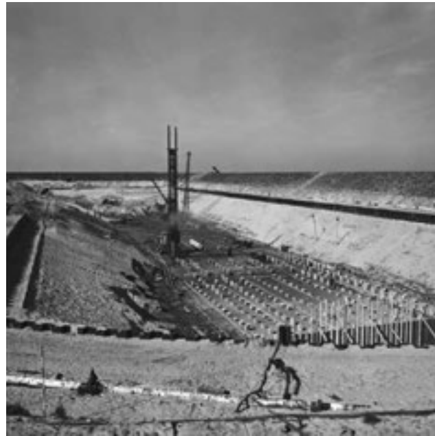
bouwput sluiscomplex bij Bruinisse [RWS]
