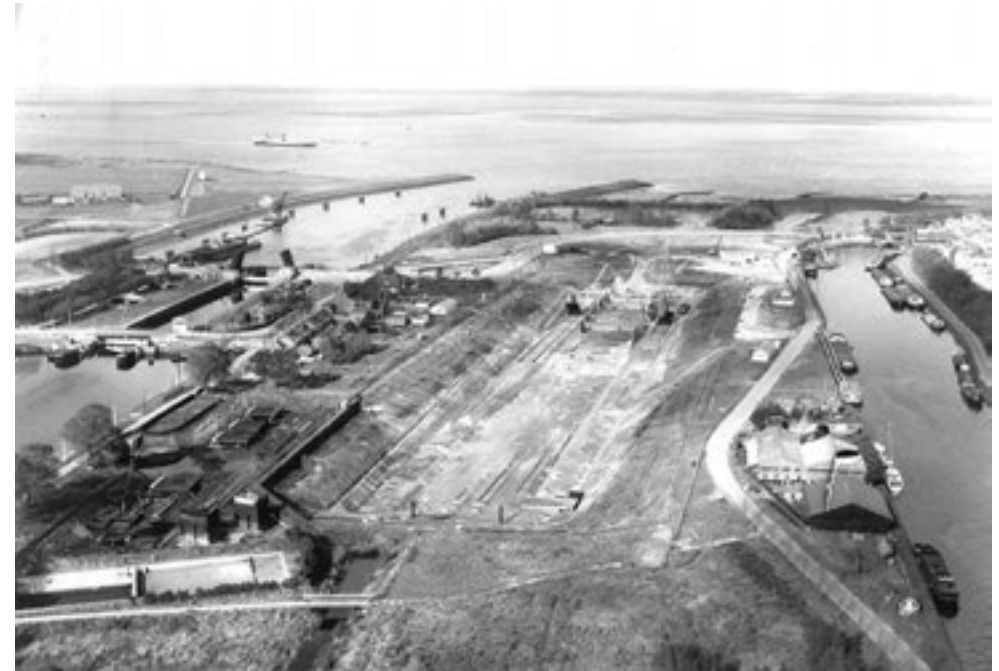
bouwput voor de oostelijke sluis, links de Middensluis [RWS]
