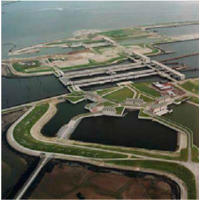
het sluisencomplex in aanbouw [RWS]
