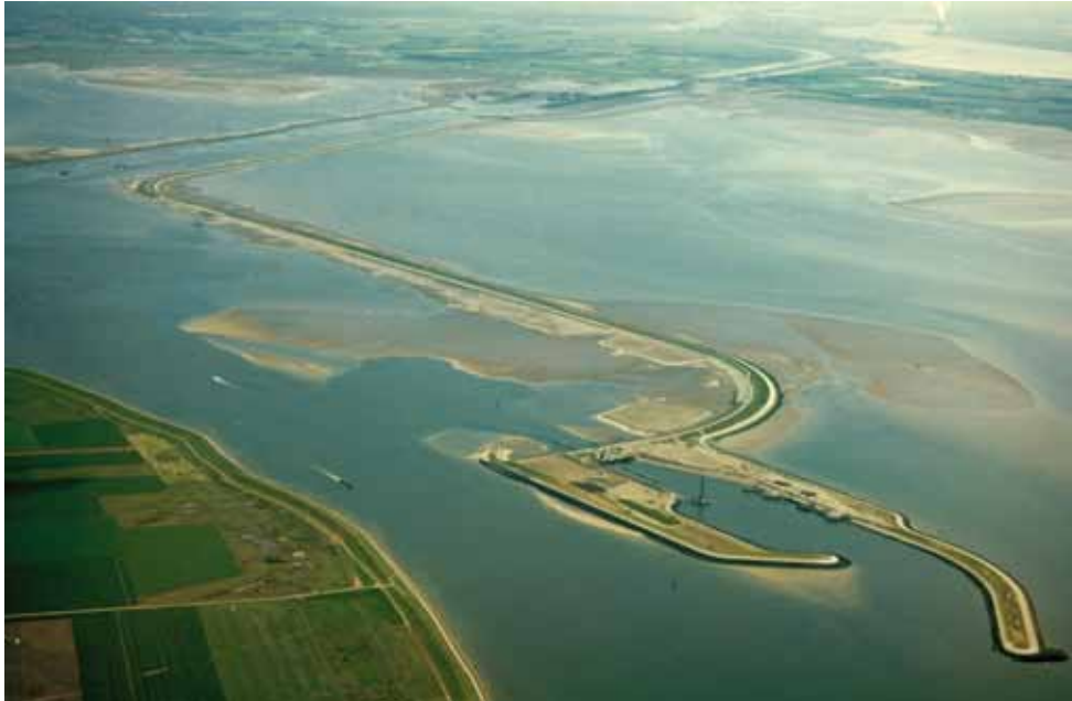
bijna voltooide Oosterdam met op de voorgrond nog open het Tholense Gat [RWS]
