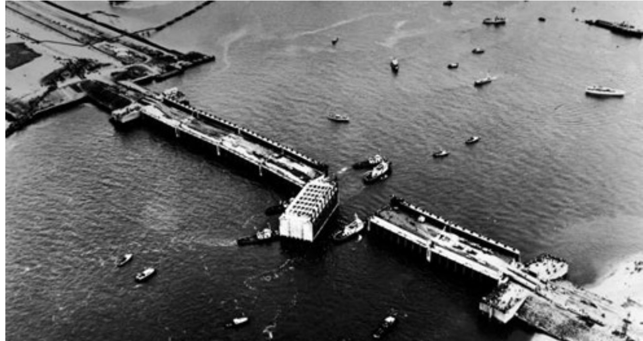
sluiting van het sluitgat met een doorlaatcaisson [RWS]
