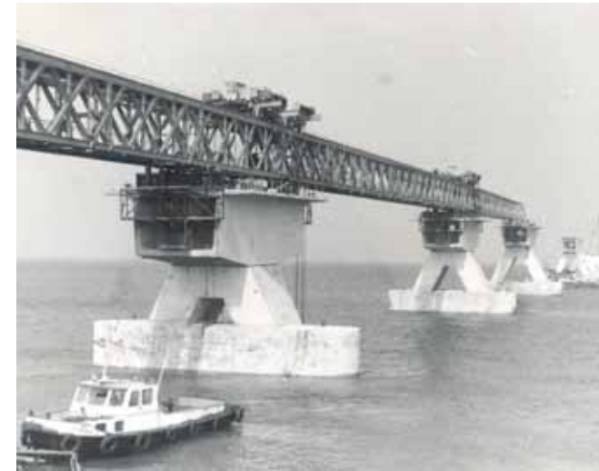
brug in aanbouw [Deltaberichten]
