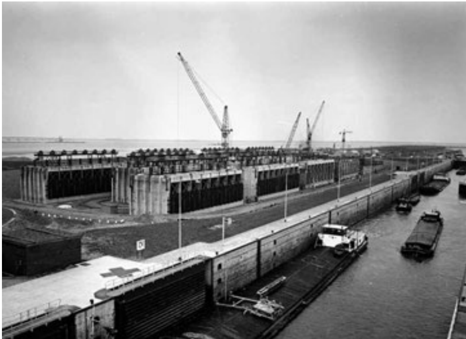
doorlaatcaissons op de bouwplaats tussen de sluisen [RWS]
