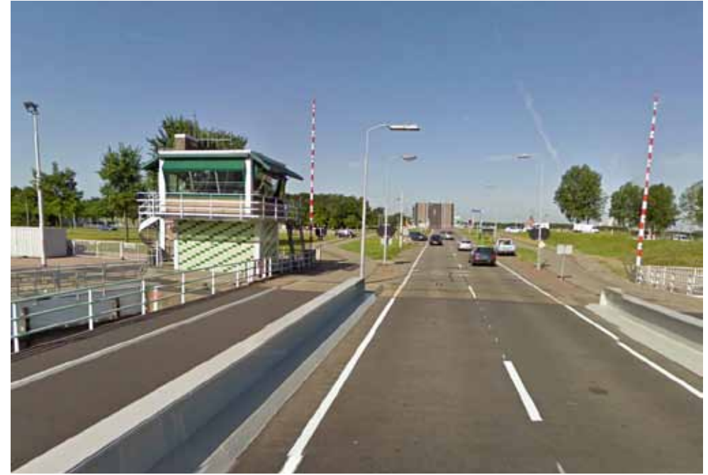
beweegbare brug Oostsluis met links het groen betegelde bedieningsgebouw
