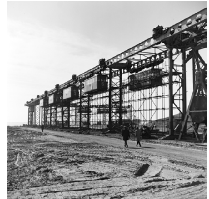
kabelbaan voor de noordelijke sluiting [RWS]
