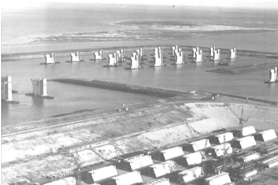
bouw van de pijlers op het werkeiland [Deltaberichten]
