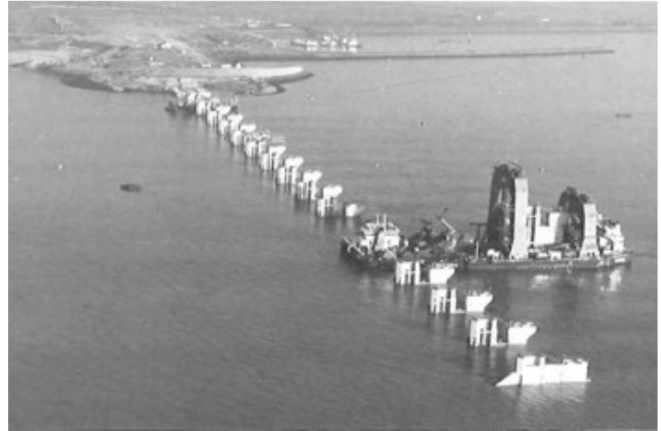
pijlers worden in positie gebracht [Deltaberichten]
