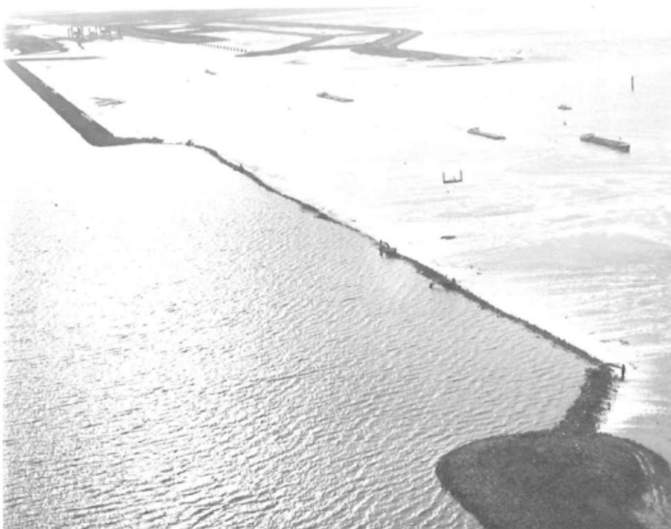
sluitgat van de Markiezaatskade [Deltaberichten]
