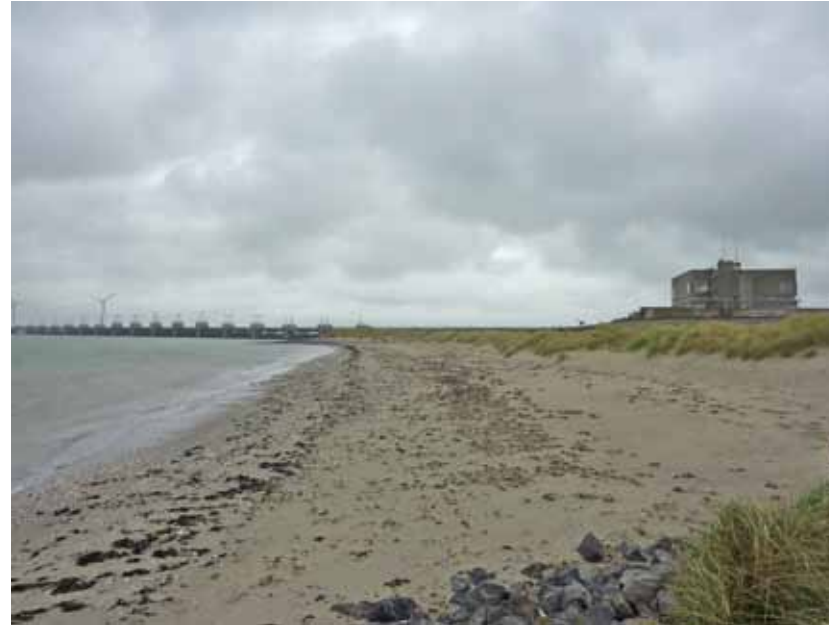
het dienstgebouw (het Ir. J.W. Topshuis) met de kering links
