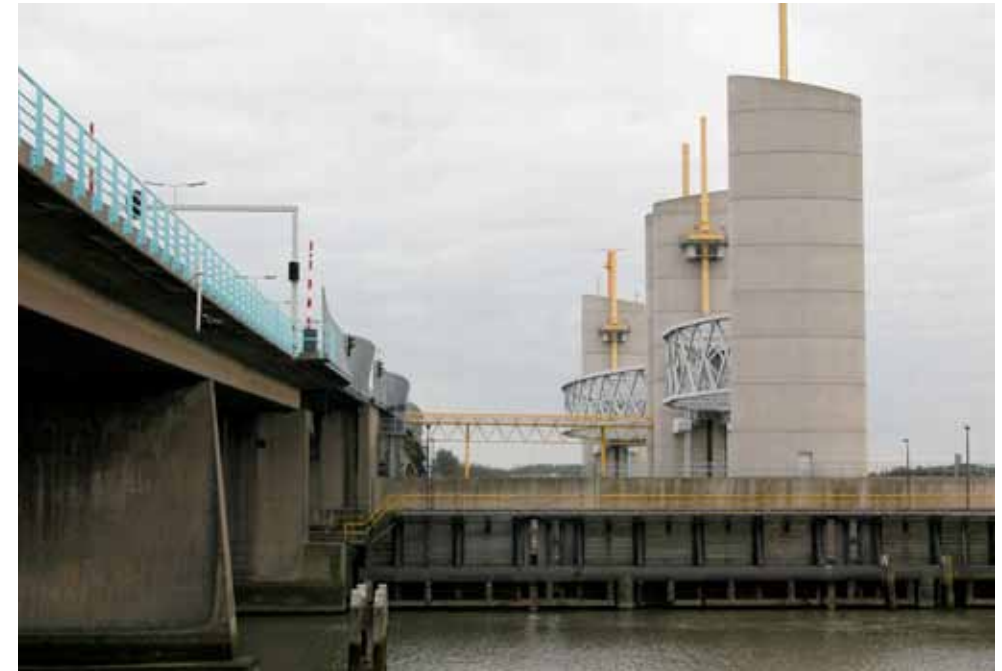
links de Hartelbrug, rechts de Hartelkering [RWS]
