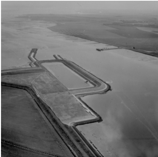
bouwput van de sluis [RWS]
