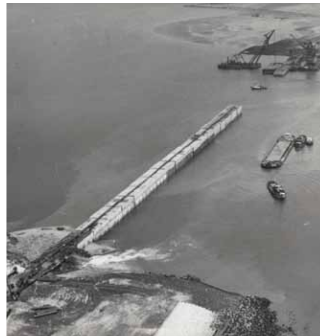
caissonsluiting bij het zuidelijke sluitgat [RWS]
