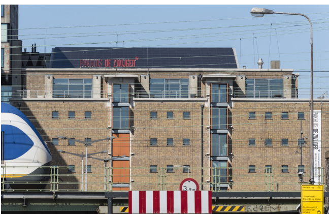
Panelen in het zicht en dakvullend op een industrieel monument
