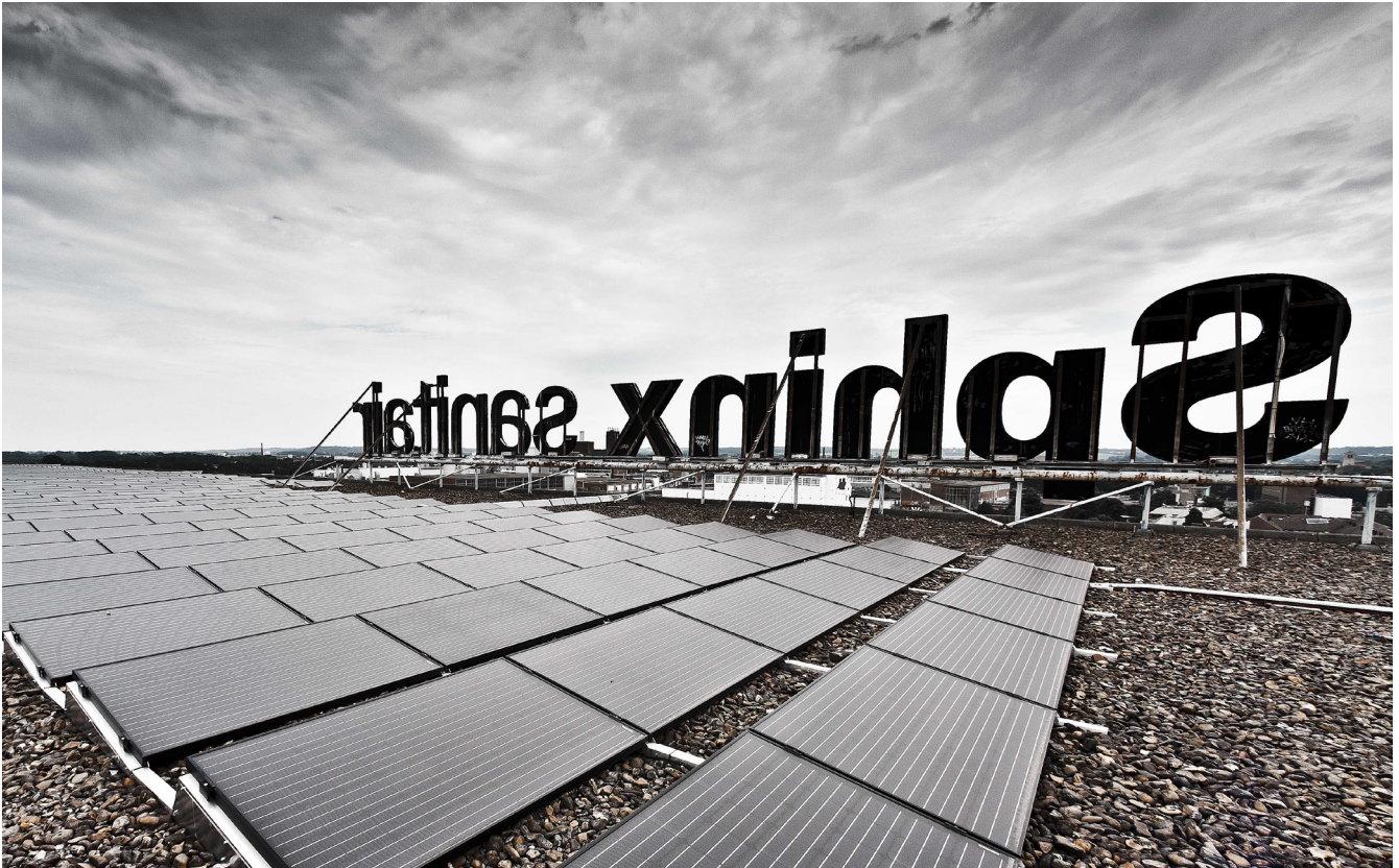
Zonnepanelen voor stroomopwekking
