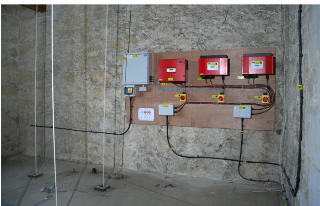
Drie omvormers en meer op een houten onderconstructie
