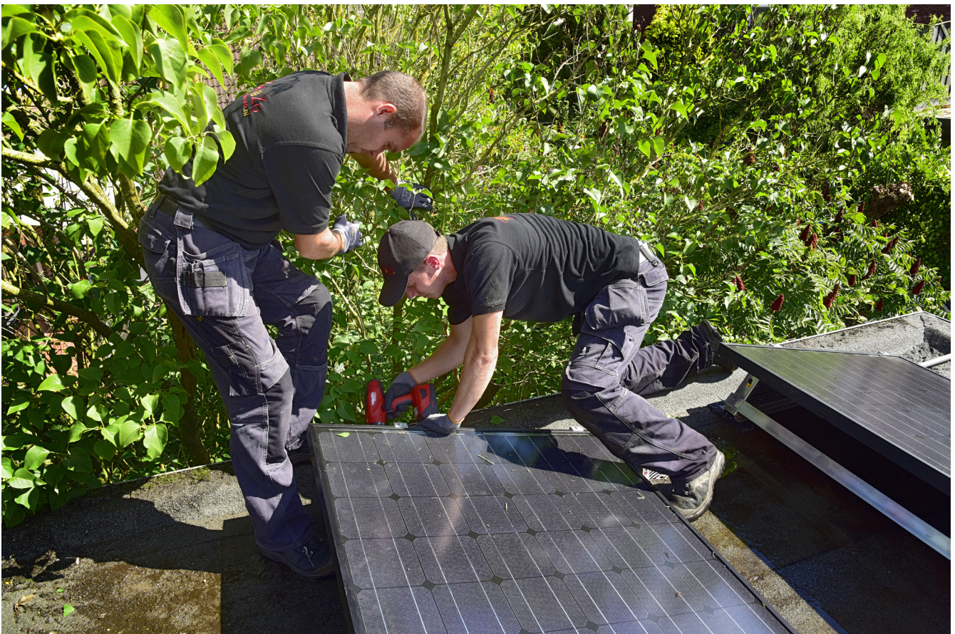
Installateurs aan het werk
