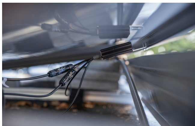
Power optimizer aan de achterkant van een zonnepaneel
