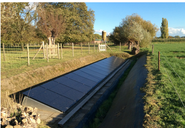
Verdiepte plaatsing van panelen in een weiland om ze van veraf uit het zicht te houden
