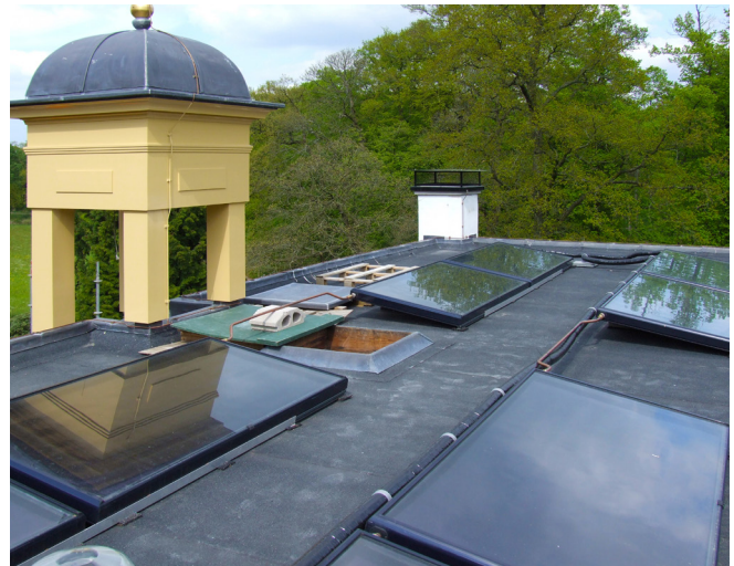
Vlakkeplaatcollectoren voor warmtewinning
