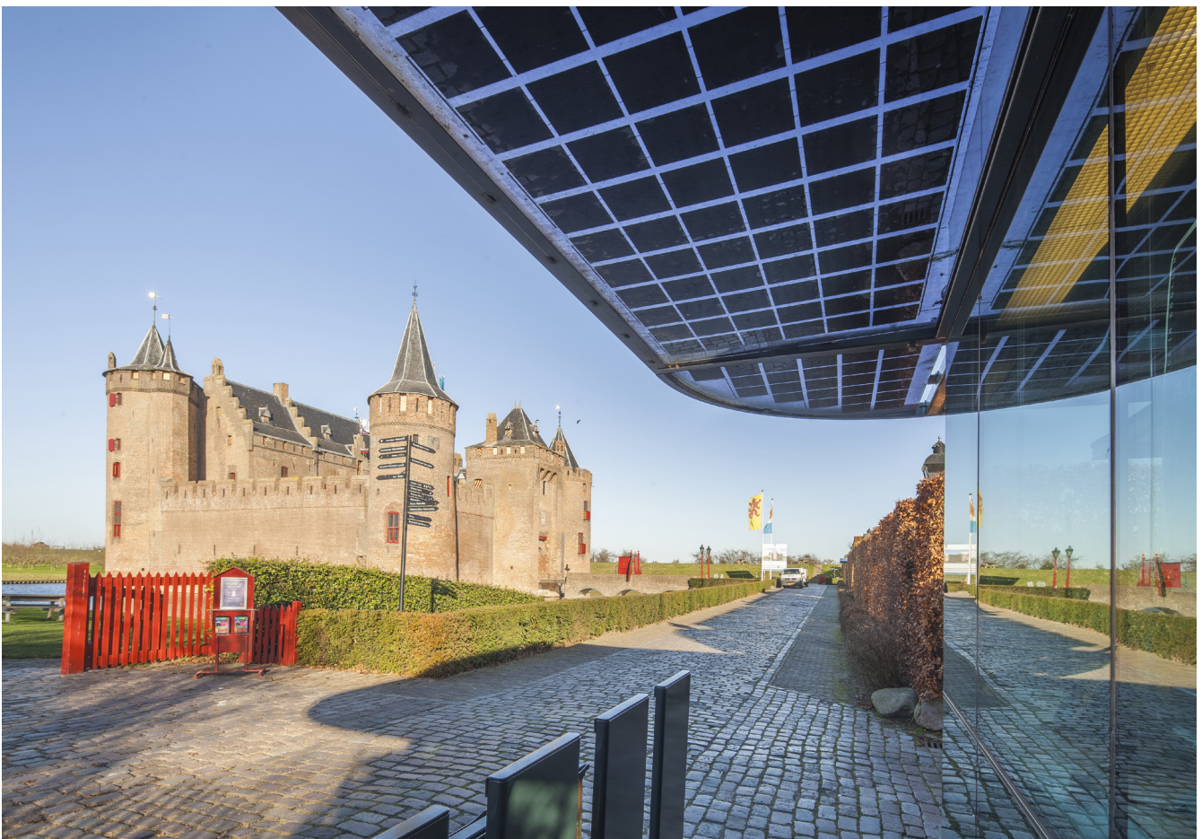
Pv-glas in nieuwbouw op het terrein
