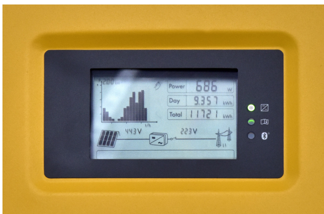
Beeldschermje op een omvormer met de stroomopbrengst van panelen
