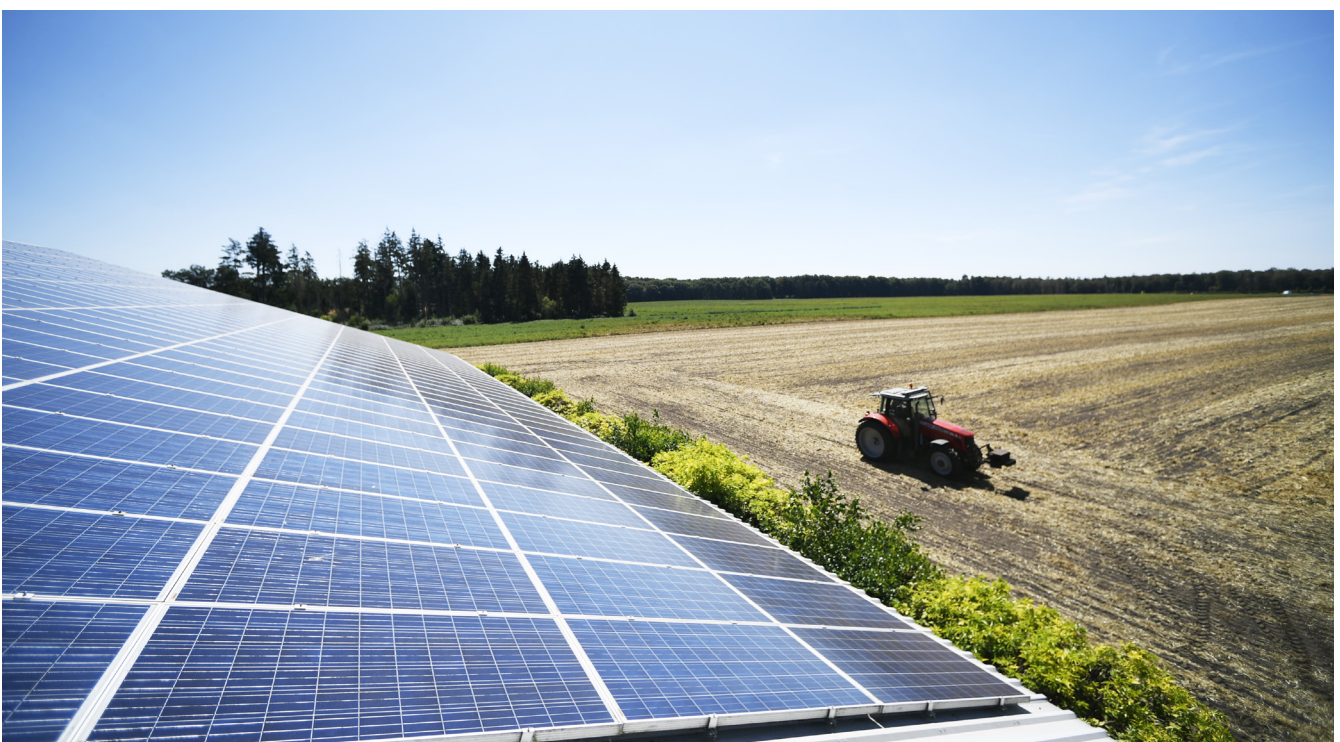
Collectieve zonnestroom-installatie voor de buurt, op een moderne agrarische schuur in een niet-beschermd gebied
