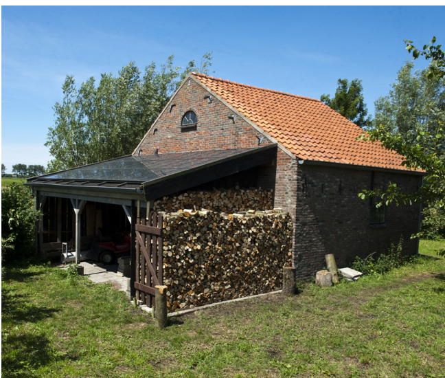
Zonnepanelen op een minder belangrijk bijgebouw
