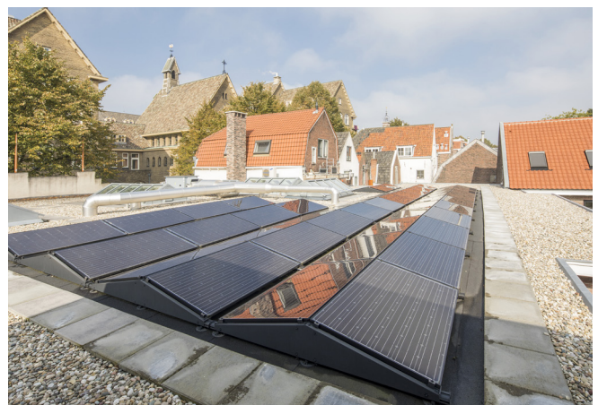
Oost-west-opstelling van zonnepanelen op een plat dak
