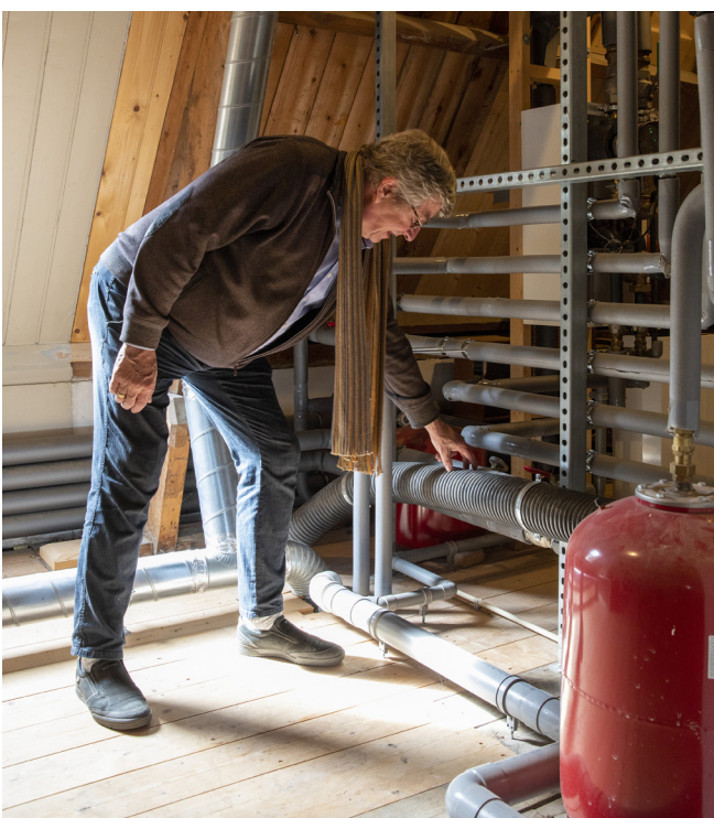
Goed geïsoleerde leiding naar het warmwatervat van een zonnecollectorsysteem
