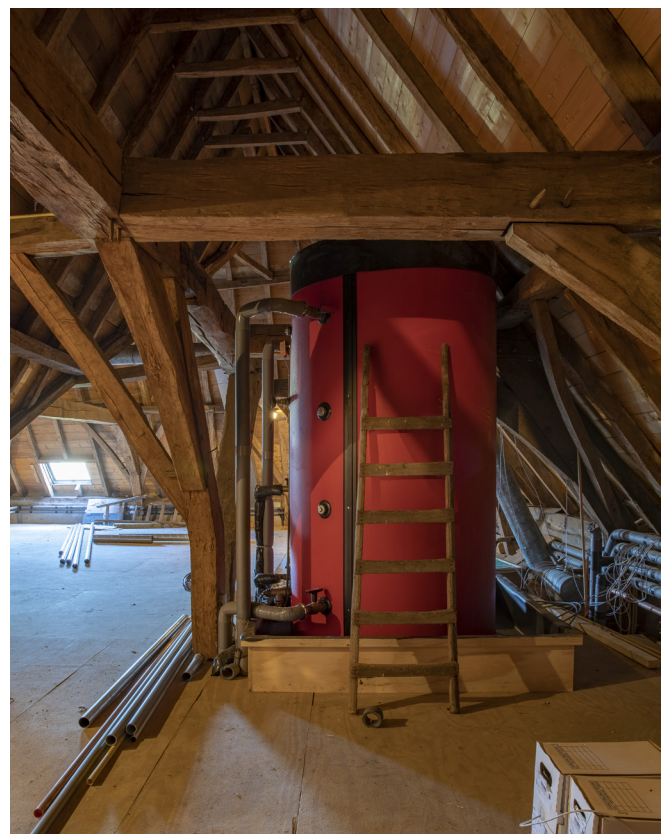
Voorraadvat met warm water – hier extra groot – op een zolder
