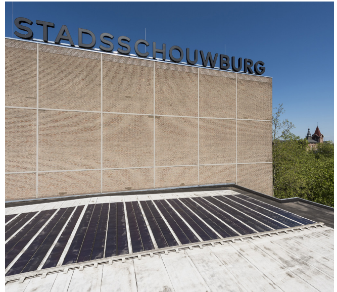
Pv-folie voor stroomopwekking op een plat dak
