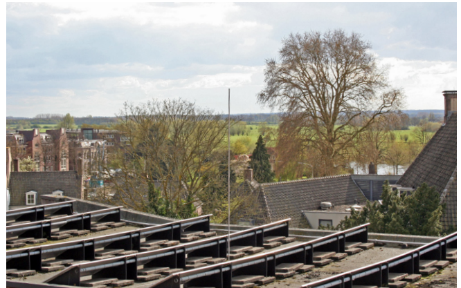
Bliksemafleider om zonnepanelen te beschermen tegen inslag
