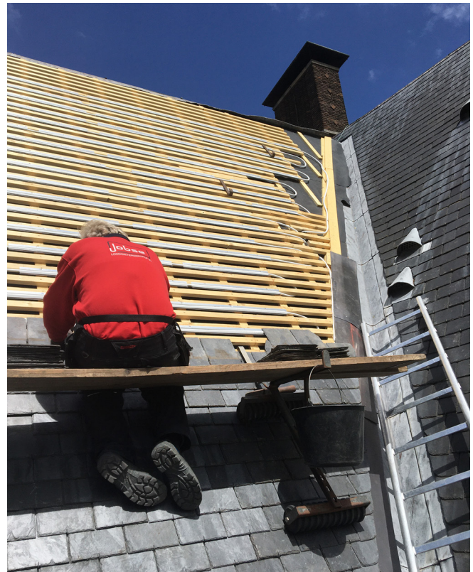
Zonthermisch daksysteem voor onder dakpannen en – zoals hier – leien
