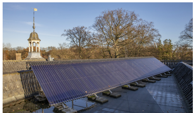
Vacuümbuiscollectoren voor warmtewinning
