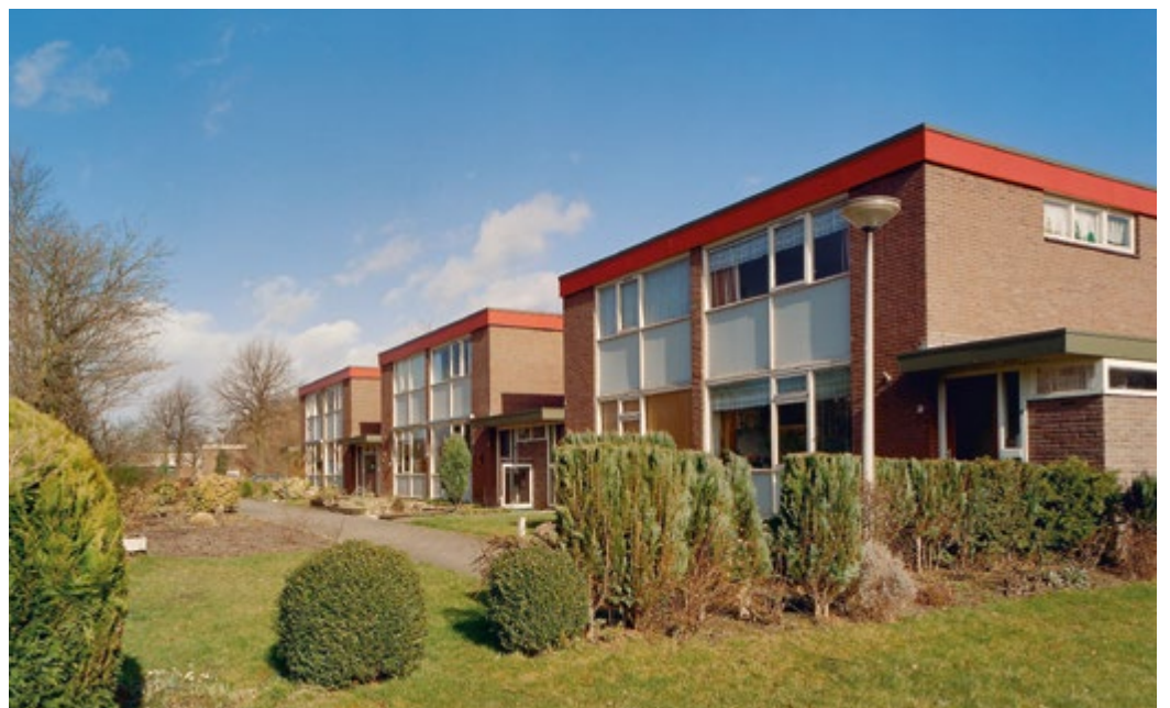
De geribde asbest-gevelplaten van rond 1960 van de Karwijhof-woningen in Nagele zijn ooit vervangen door gladde platen. Nu wil men weer geribde platen aanbrengen. Daar is echter geen documentatie van
