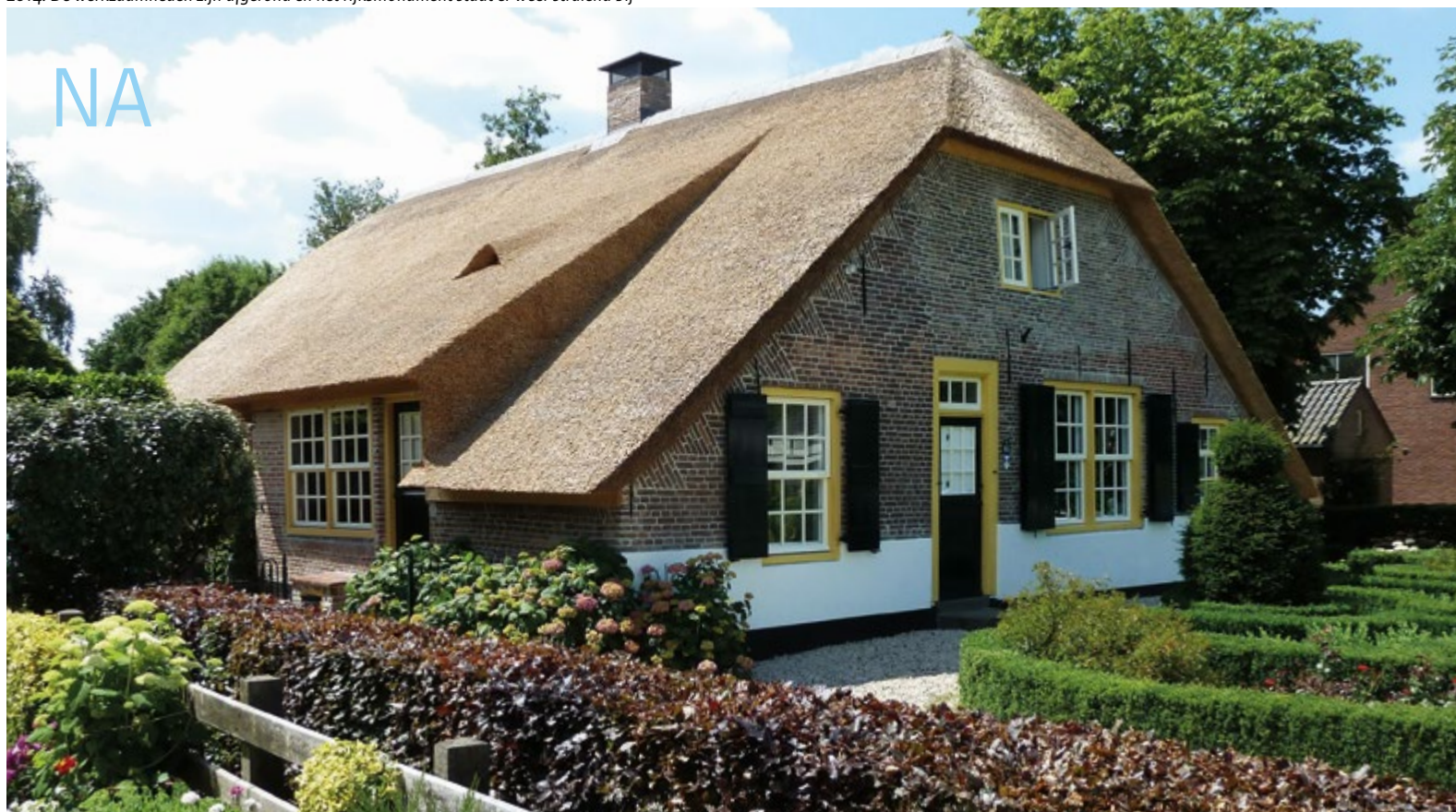
2014: De werkzaamheden zijn afgerond en het rijksmonument staat er weer stralend bij
