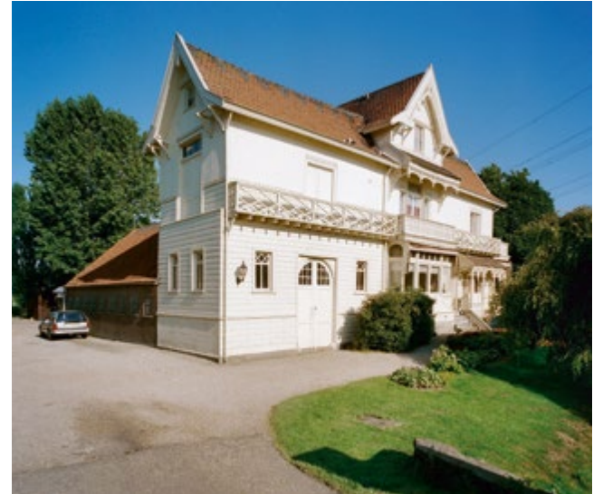
Kringenwet-boerderij Villa Vechthoeve bij Muiden is driehonderd meter opgeschoven vanwege de verlegging van de A1
