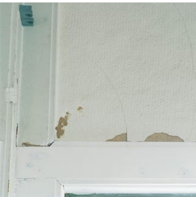
Zachtboard in een monumentaal seinhuis in Groningen
