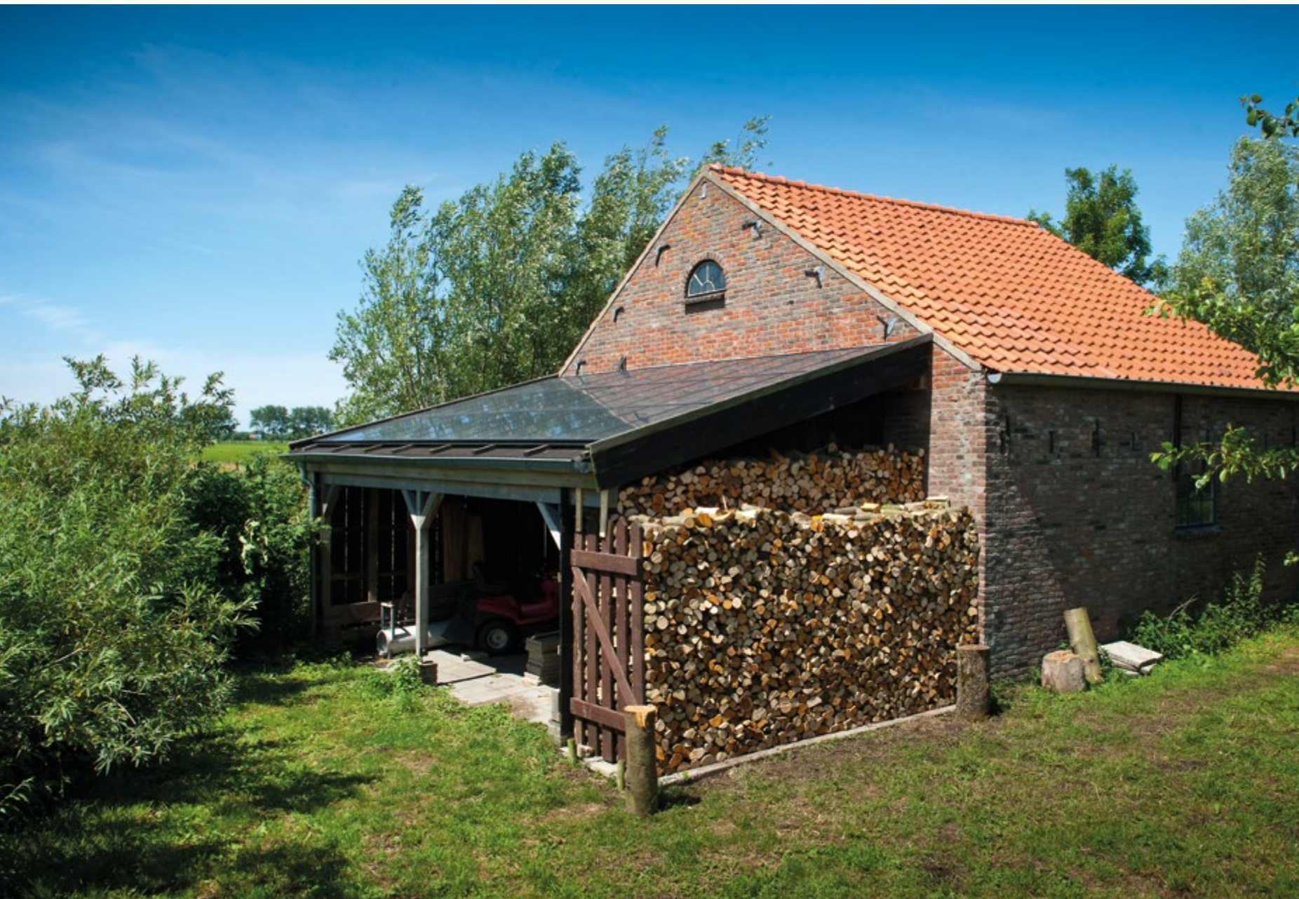
Zonnepanelen op een minder belangrijk dakvlak van een schuur, met aanpassingen om ze onopvallender te maken: ze zijn niet helderblauw, maar zwart, de randen zijn donker en het gebruikelijke rasterpatroon ontbreekt
