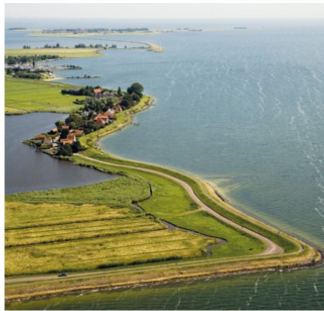
De Waterlandse Zeedijk beschermt de streek Waterland bij Amsterdam sinds de middeleeuwen tegen het water
