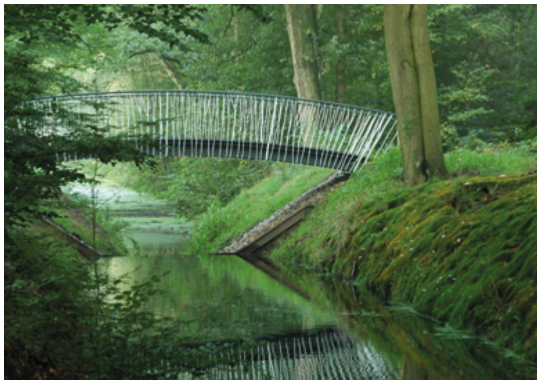
Het grand canal is voorzien van een nieuwe takkenbrug met metalen spijlen, gemodelleerd naar de oorspronkelijke houten reling
