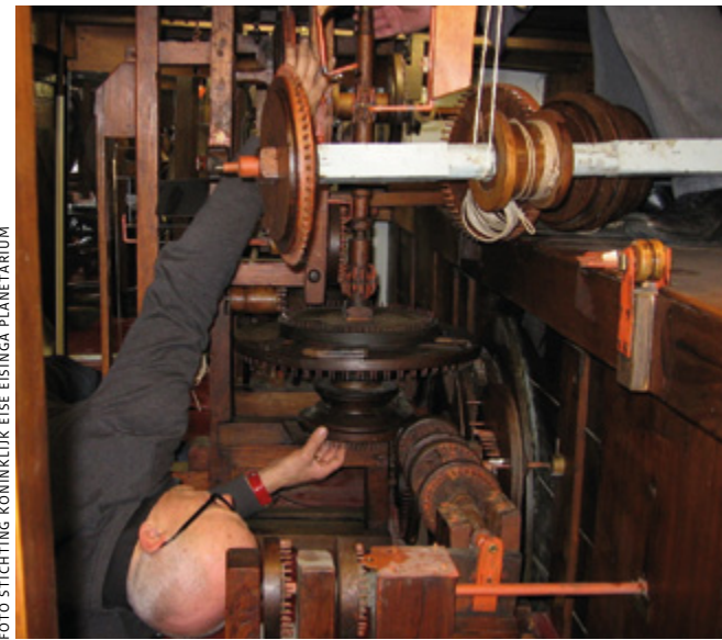
Het mechaniek op de eerste verdieping in onderhoud
